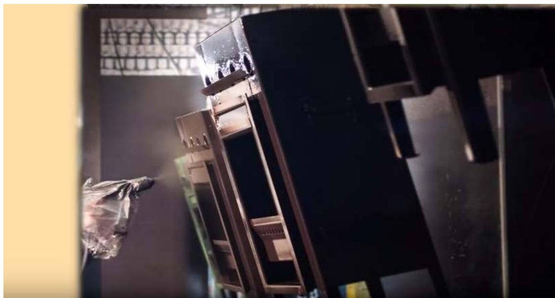
**Slika 37. Nanošenje tekućih vatro otpornih boja**
