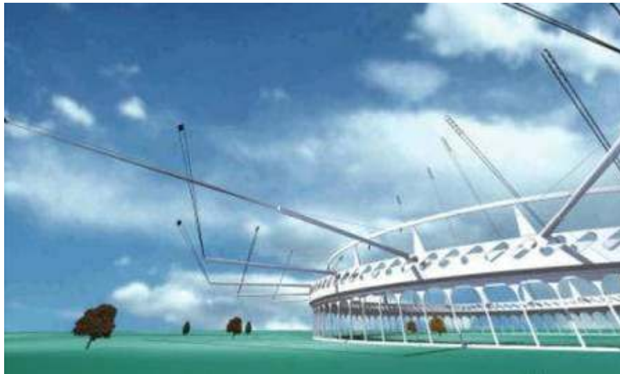
Slika 21: KiteGen kao "vrtuljak" za primjenu na kopnu
