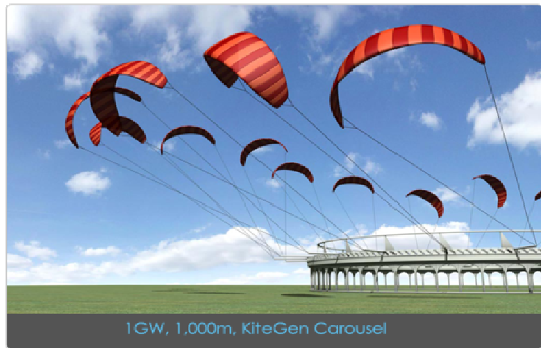
Slika 16: Vjetroagregat s nekoliko Kiteova
