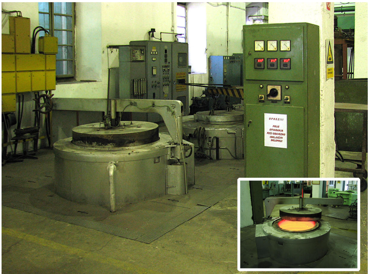
Slika 21. Peć za zagrijavanje pougljičenih obradaka
