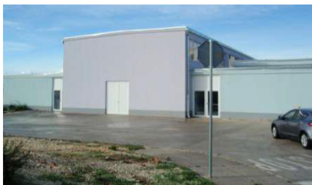
Slika 36. Istočno pročelje Industrijsko - obrtničke škole Pula nakon rekonstrukcije
