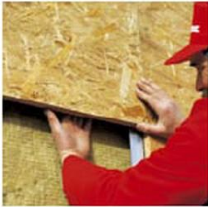
Ventilirani toplinsko izolacijski sustav
