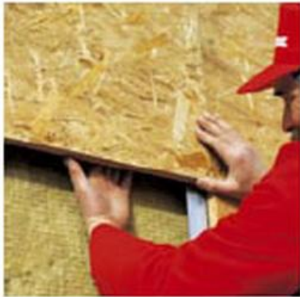
Ventilirani toplinsko izolacijski sustav
