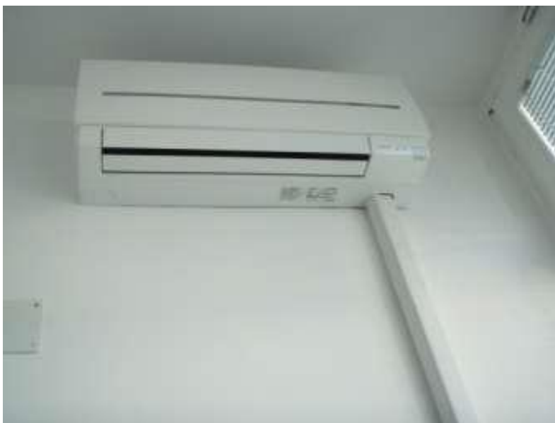
Slika 52. Unutarnja jedinica
