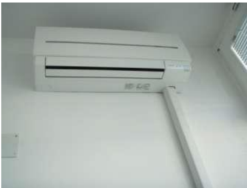
Slika 52. Unutarnja jedinica
