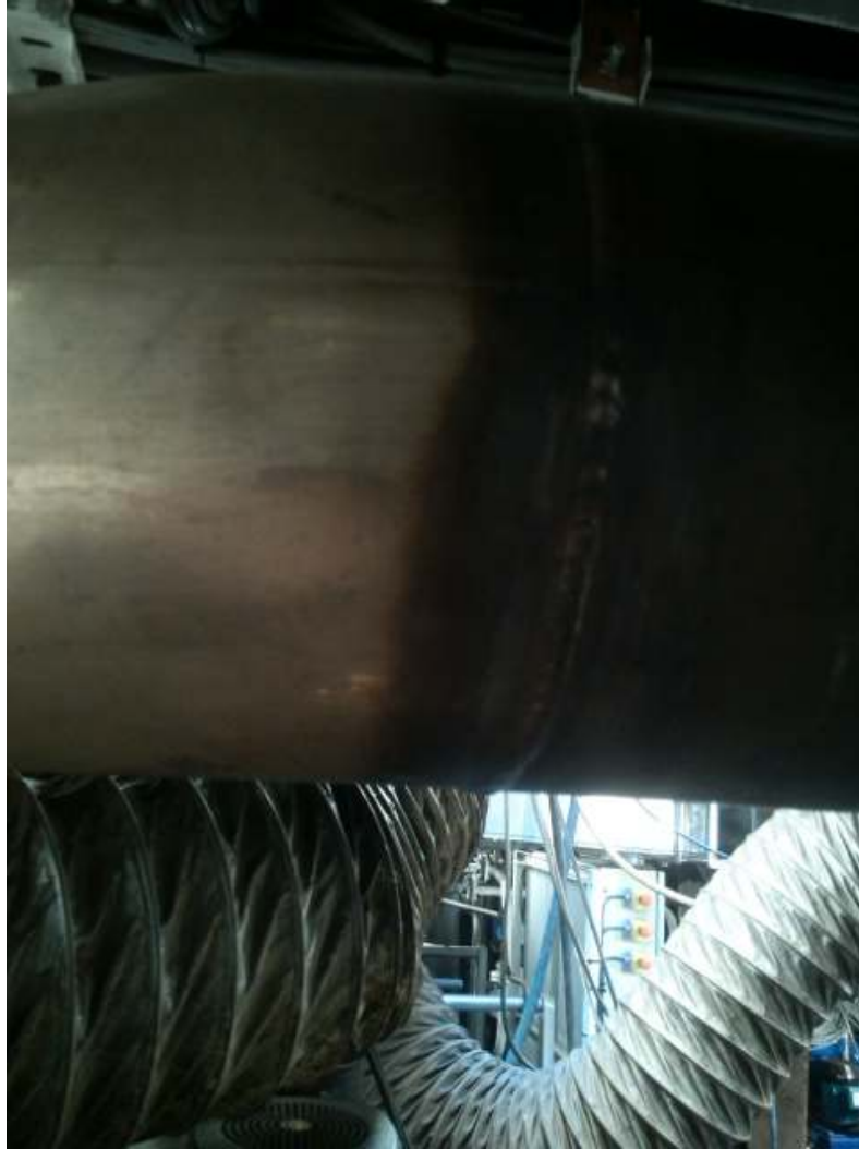
Slika 20. Stični zavareni spoj na cijevi cunifera
