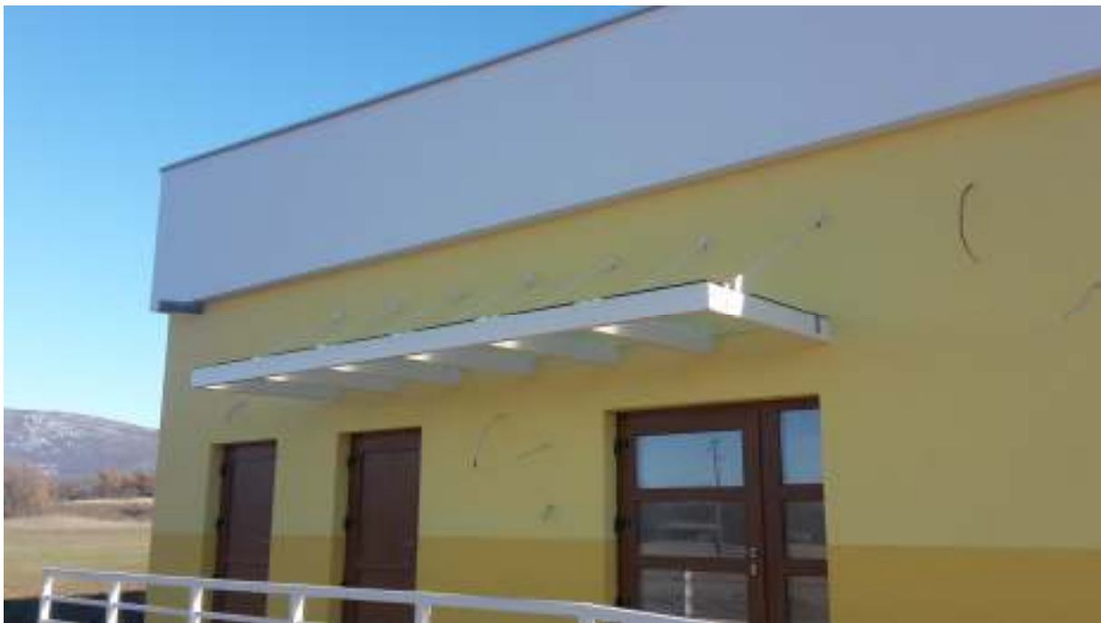
Slika 23: Montirana nadstrešnica
