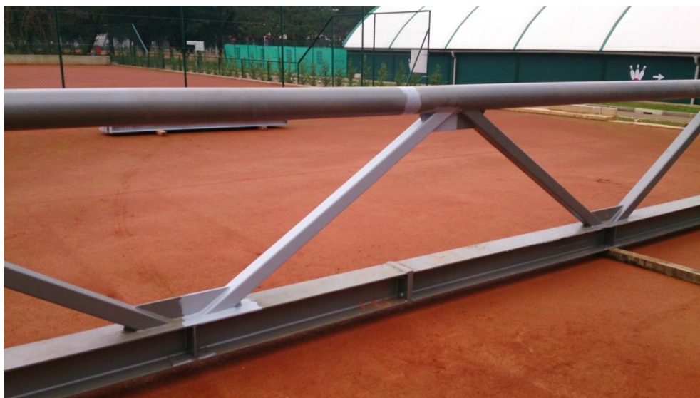
Slika 18. Prikaz naknadnog spoja krovnog nosača
