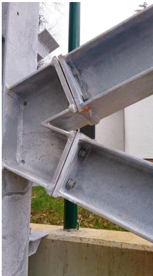
Slika 20. Detalj vijčanog spoja [7]
