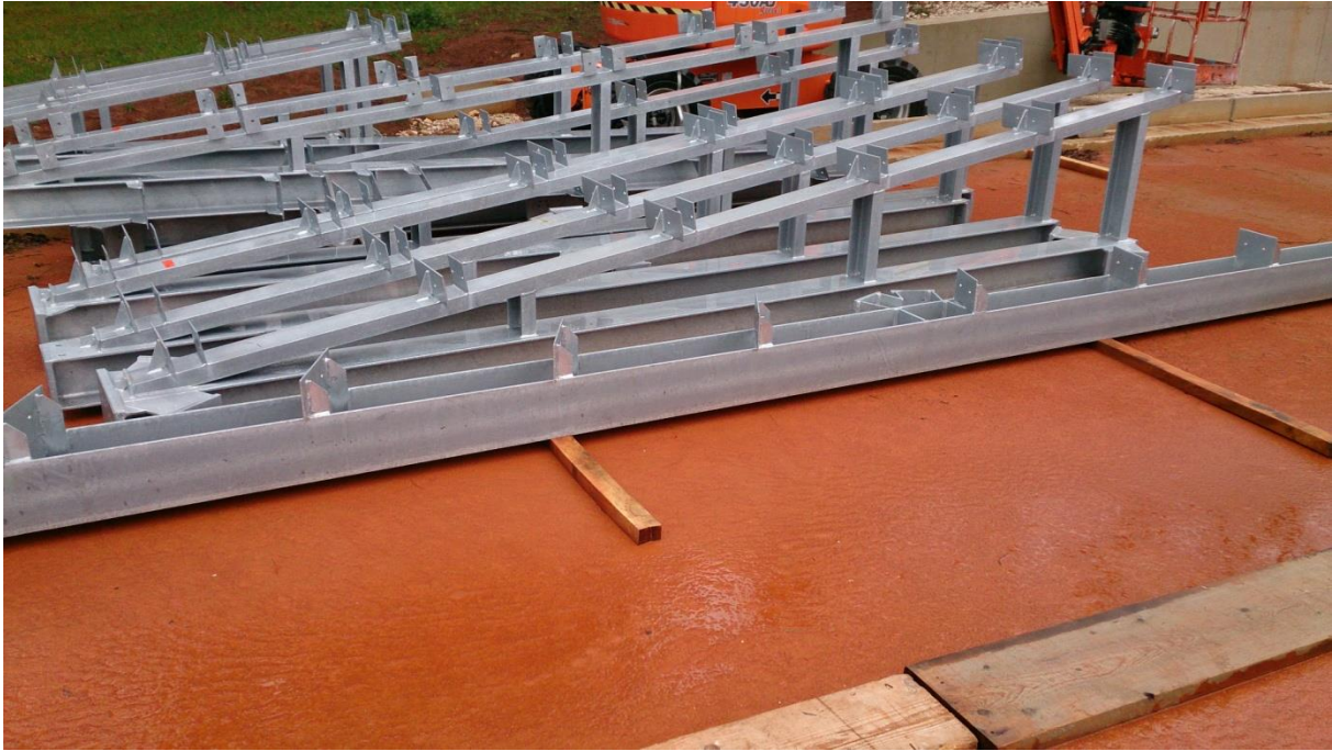
Slika 17. Prikaz izrađenog i pocinčanog segmenta
