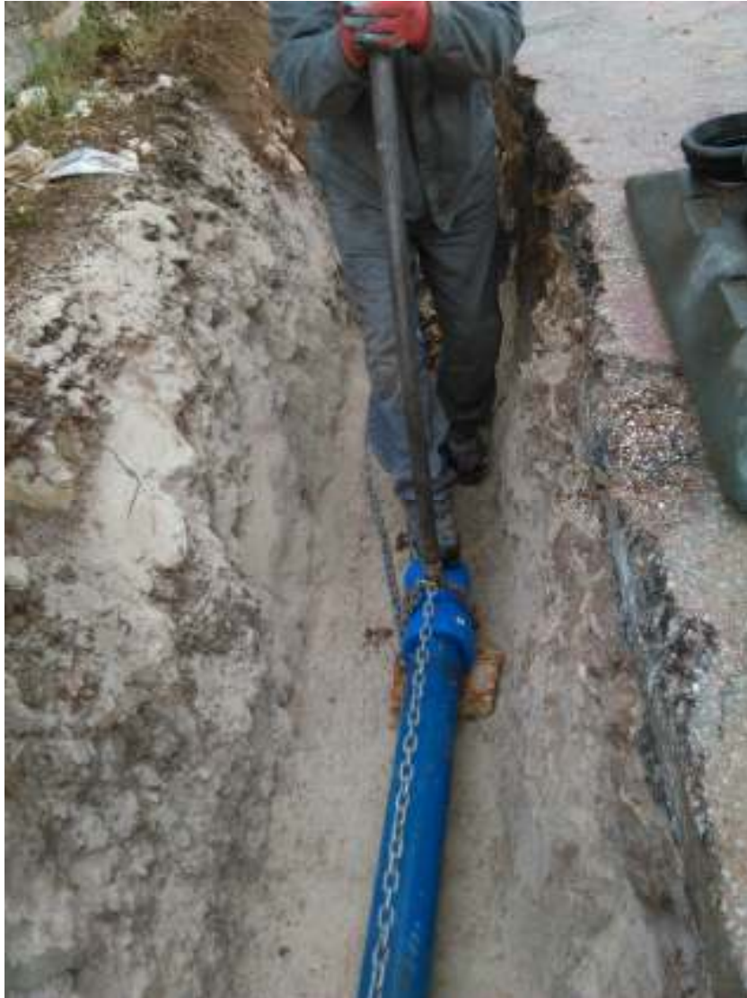
Slika 6.4.3. Spajanje fazona napravom kućne izrade [3]
