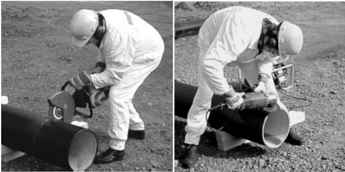
Slika 6.4.1. Primjer rezanja i skošivanja cijevi [8]
