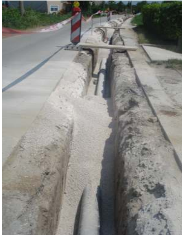
Slika 6.6.1. Primjer djelomičnog zatrpavanja rova [3]
