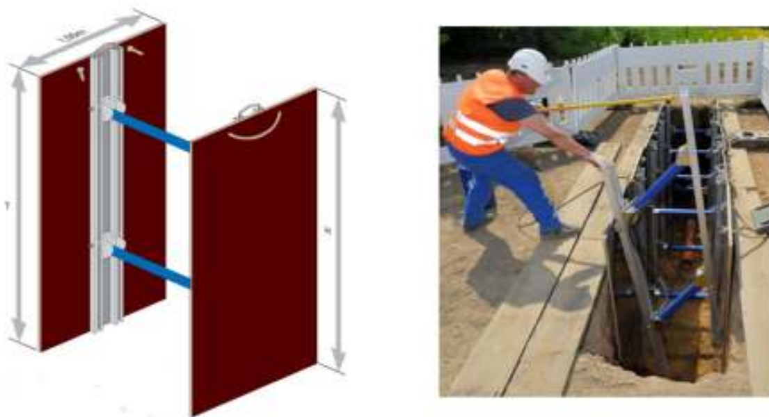
Slika 4.3.1. Predgotovljeni sistem za razupiranje i ugradnja [5]
