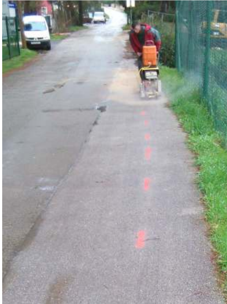
Slika 6.2.2.2. Primjer rezanja asfaltnog sloja motornom rezačicom [3]
