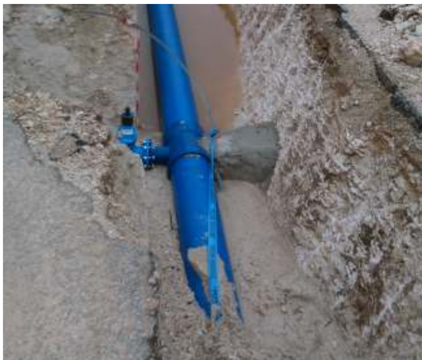
Slika 6.5.3. Betonski uporište fazona od nodularnog lijeva [3]
