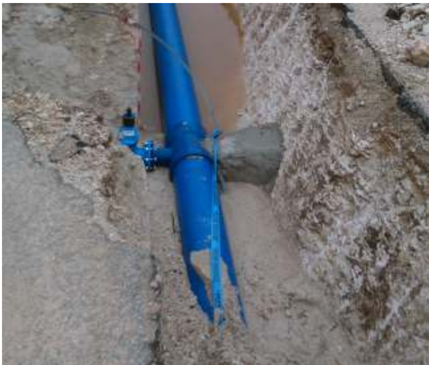
Slika 6.5.3. Betonski uporište fazona od nodularnog lijeva [3]
