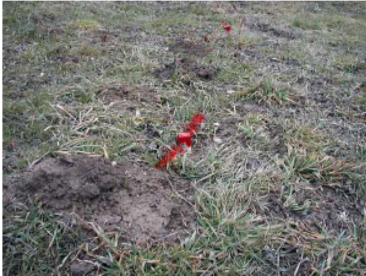
Slika 4.1.1.1. Iskolčenje cjevovoda – primjer na zemljanoj površini [2]
