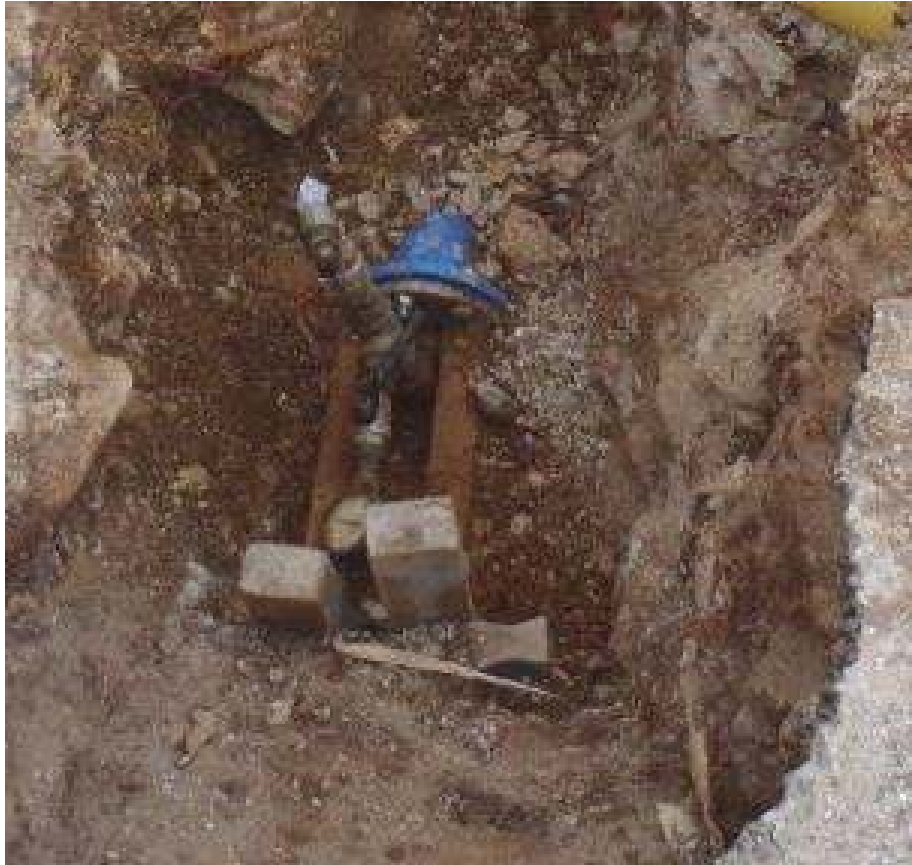
Slika 6.7.1. Privremeni ventil za tlačnu probu [3]
