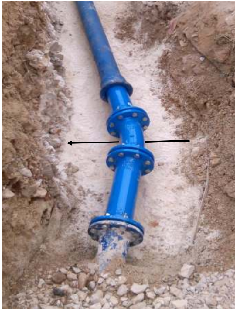
Slika 6.5.1. Nastavak čvora 4 prema podzemnom hidrantu [3]
