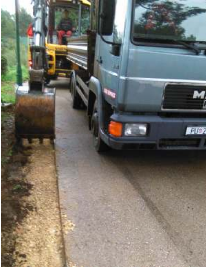
Slika 6.2.2.3. Primjer strojnog uklanjanja asfaltnog sloja [3]
