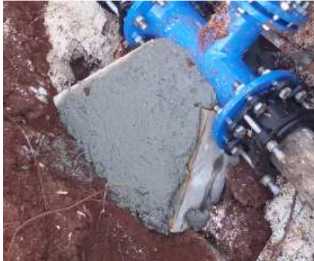
Slika 6.5.4. Primjer zaštite vijaka kod izrade betonskog uporišta [3]
