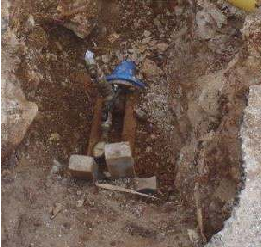
Slika 6.7.1. Privremeni ventil za tlačnu probu [3]
