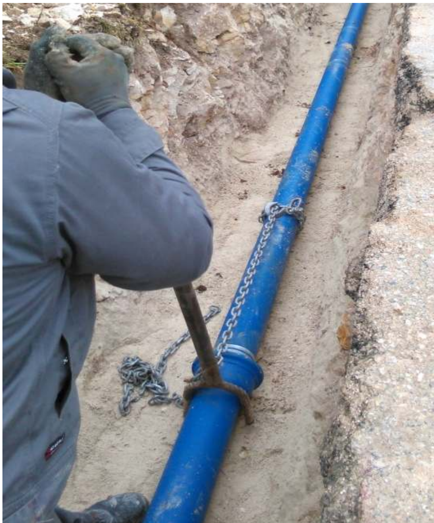
Slika 6.4.2. Naprava za spajanje cijevi sa naglavkom [3]
