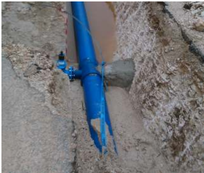
Slika 6.5.3. Betonski uporište fazona od nodularnog lijeva [3]
