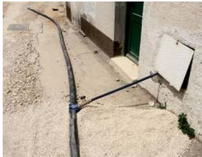
Slika 4.9.1. Primjer obilaznog voda (bypass) [3]
