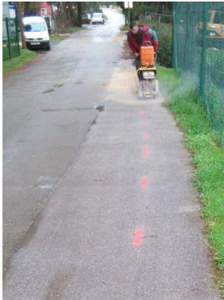
Slika 6.2.2.2. Primjer rezanja asfaltnog sloja motornom rezačicom [3]
