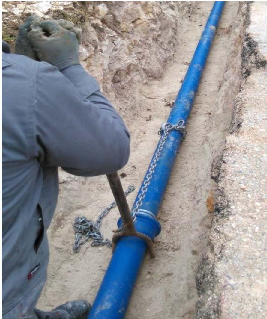
Slika 6.4.2. Naprava za spajanje cijevi sa naglavkom [3]
