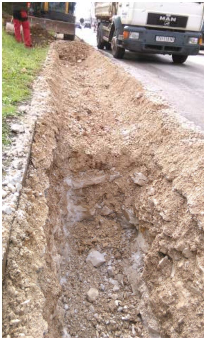
Slika 6.3.1. Primjer uklanjanja mekanog sloja materijala rova [3]
