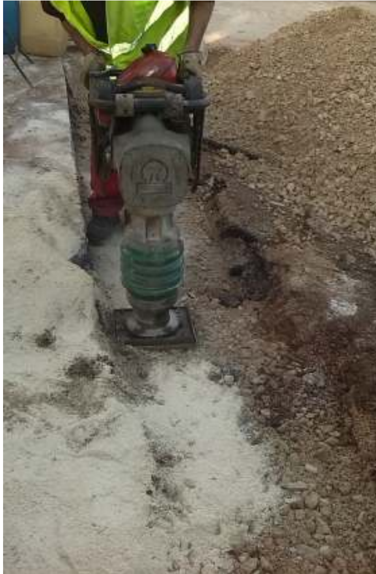
Slika 6.6.3. Sabijanje materijala u rovu u slojevima [3]
