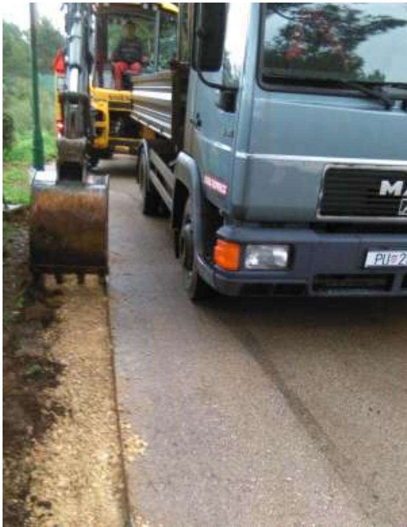
Slika 6.2.2.3. Primjer strojnog uklanjanja asfaltног sloja [3]
