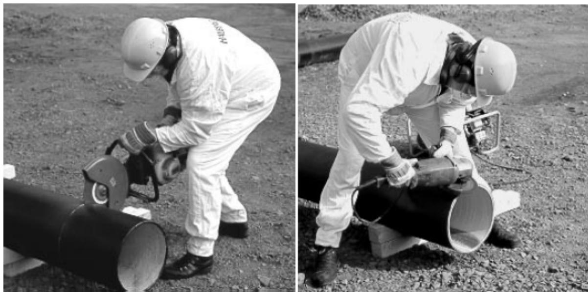
Slika 6.4.1. Primjer rezanja i skošivanja cijevi [8]
