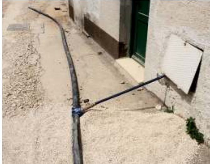
Slika 4.9.1. Primjer obilaznog voda (bypass) [3]
