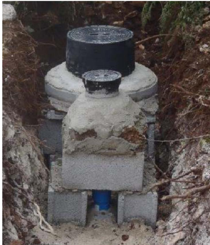
Slika 6.5.6. Zidanje podzemnog hidranta sa pripadajućim zasunom [3]
