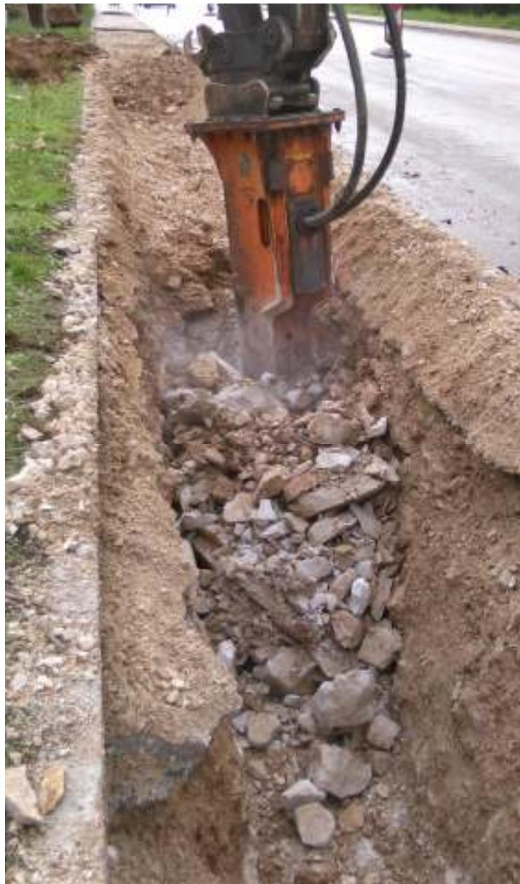
Slika 6.3.2. Primjer upotrebe hidrauličkog strojnog čekića [3]
