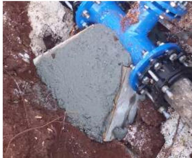
Slika 6.5.4. Primjer zaštite vijaka kod izrade betonskog uporišta [3]
