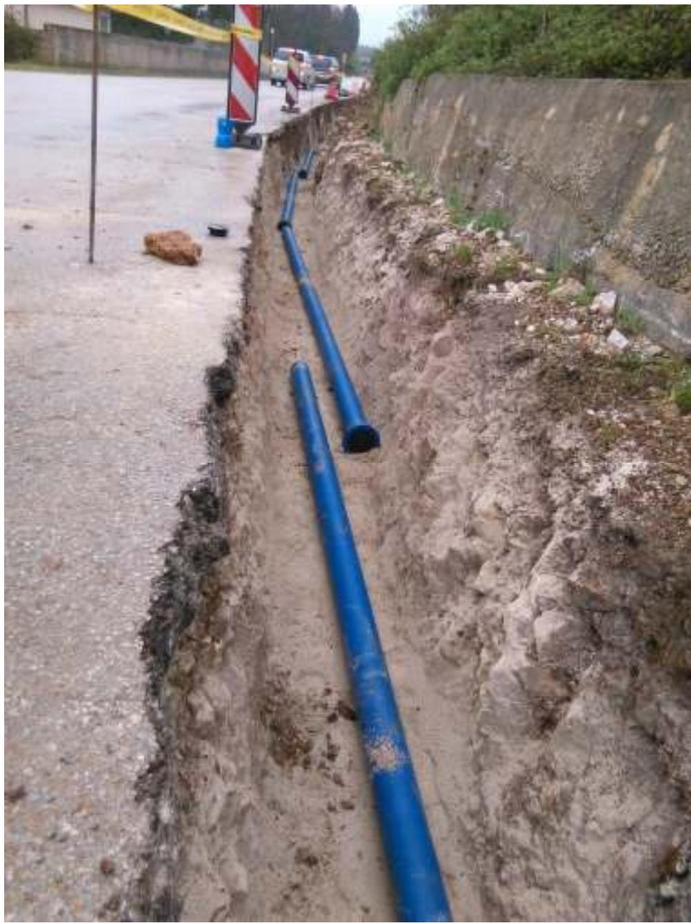
Slika 6.3.3. Položene cijevi u pripremljeni rov [3]
