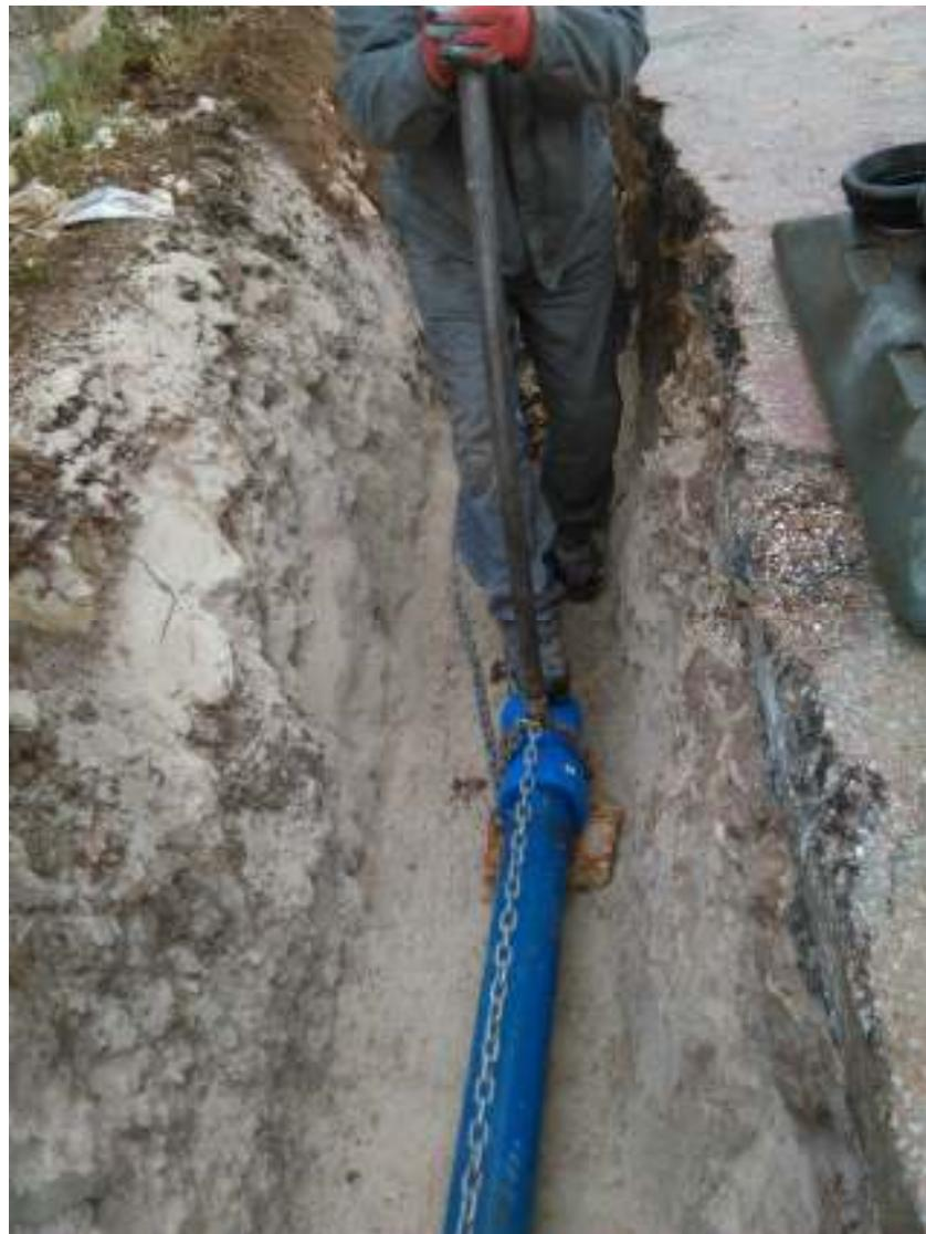
Slika 6.4.3. Spajanje fazona napravom kućne izrade [3]
