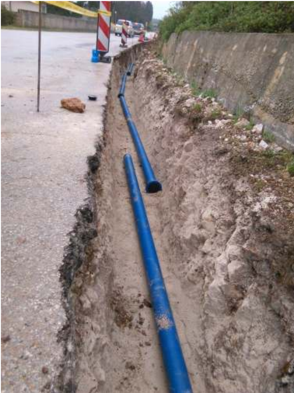
Slika 6.3.3. Položene cijevi u pripremljeni rov [3]
