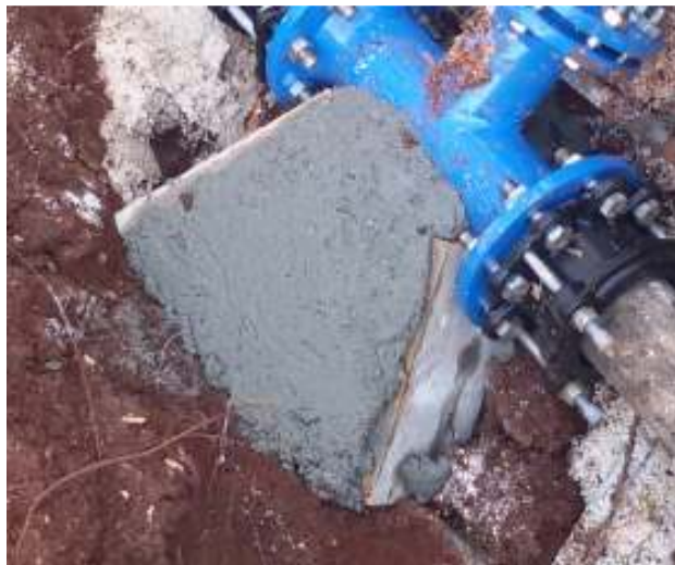
Slika 6.5.4. Primjer zaštite vijaka kod izrade betonskog uporišta [3]
