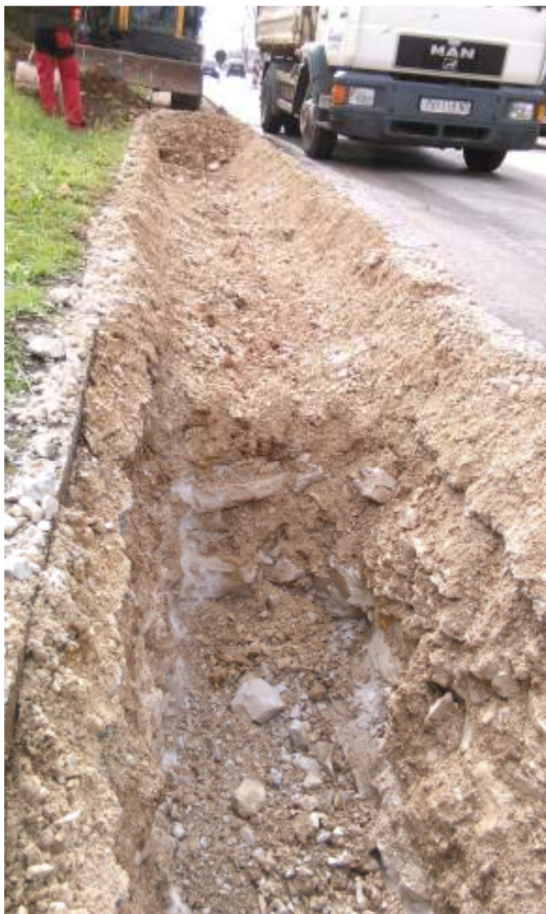
Slika 6.3.1. Primjer uklanjanja mekanog sloja materijala rova [3]
