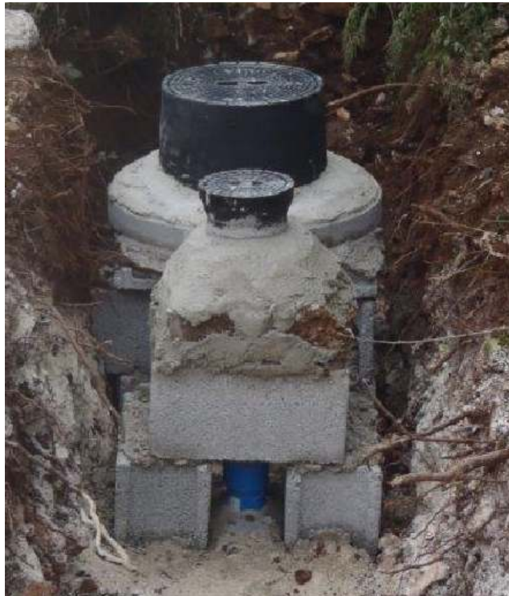
Slika 6.5.6. Zidanje podzemnog hidranta sa pripadajućim zasunom [3]
