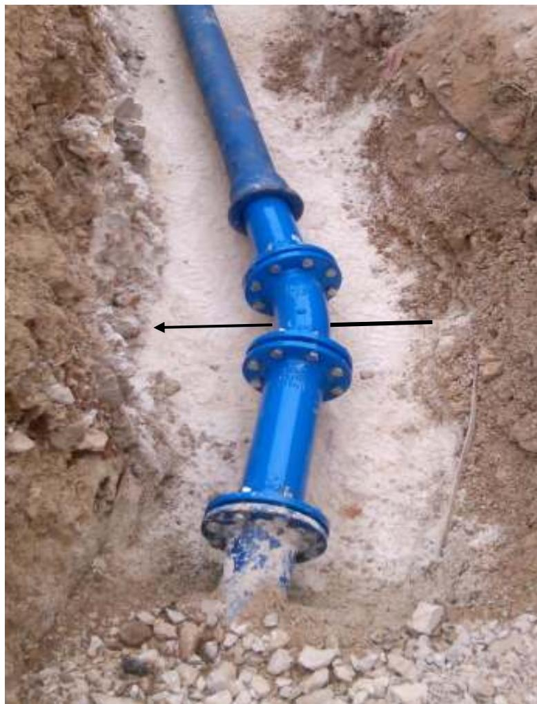
Slika 6.5.1. Nastavak čvora 4 prema podzemnom hidrantu [3]
