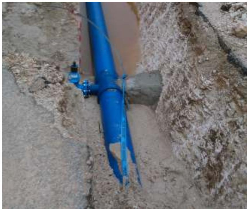
Slika 6.5.3. Betonski uporište fazona od nodularnog lijeva [3]
