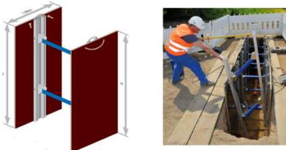
Slika 4.3.1. Predgotovljeni sistem za razupiranje i ugradnja [5]
