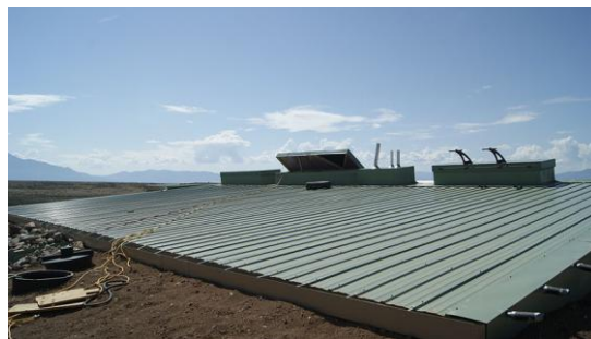
Slika 41. Postavljeni završni limeni pokrov na krov Earthshipa
