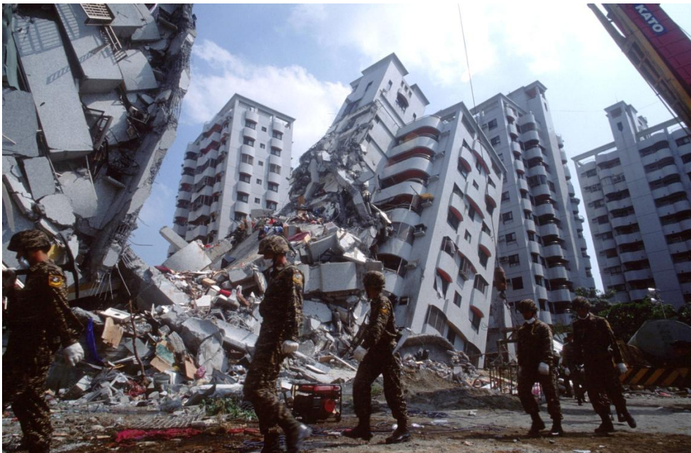
Slika 2. Učinak potresa na stambene zgrade
