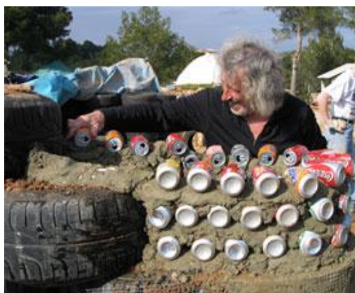
Slika 39. Zidanje zidova korištenjem odbačenih aluminijskih limenki
