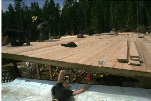
Slika 40. Postavljanje drvene oplata na krov Earthshipa
