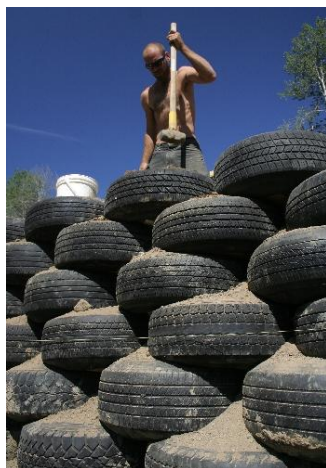
Slika 38. Izgled dijela nosivog zida načinjenog od odbačenih automobilskih guma punjenih sabijenom zemljom
