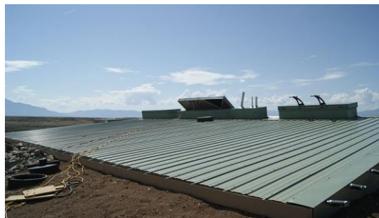
Slika 41. Postavljeni završni limeni pokrov na krov Earthshipa
