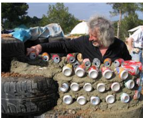
Slika 39. Zidanje zidova korištenjem odbačenih aluminijskih limenki
