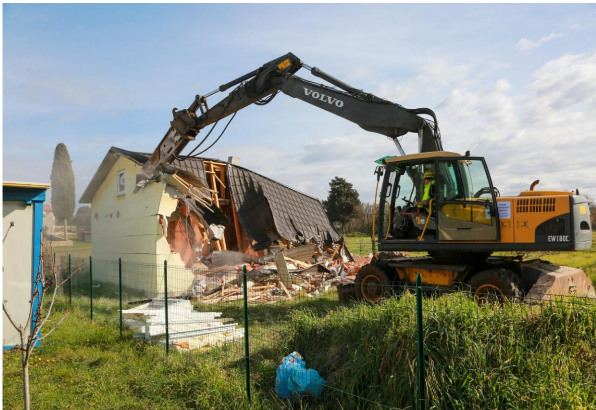
Slika 7. Rušenje bespravno sagrađene kuće
