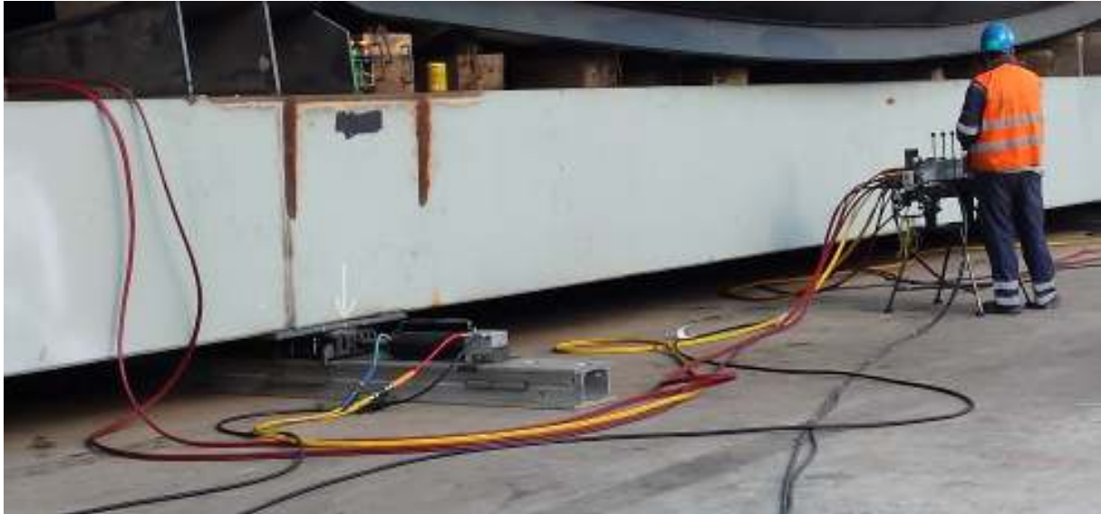
Slika 22. Prikaz aluminijskih staza s hidrauličkim cilindrima.
