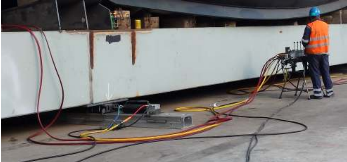
Slika 22. Prikaz aluminijskih staza s hidrauličkim cilindrima.
