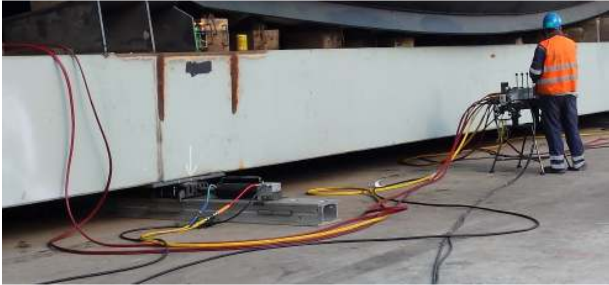
Slika 22. Prikaz aluminijskih staza s hidrauličkim cilindrima.
