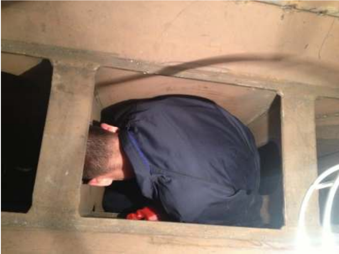
Slika 17. Nanošenje penetranta po zavarima kobilice.
