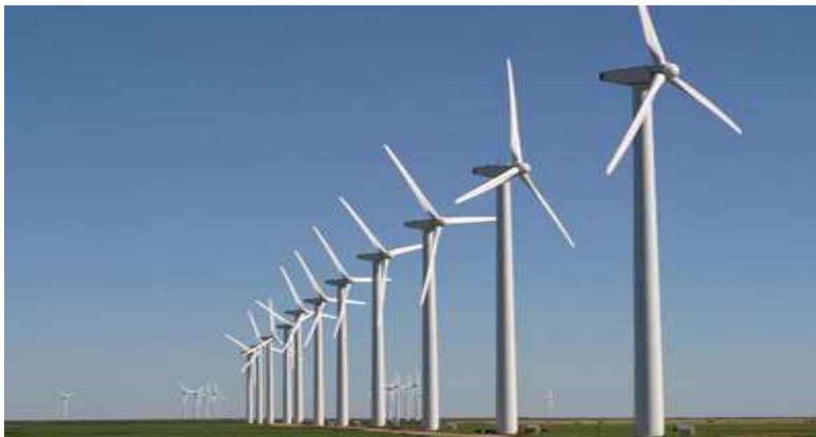
Slika 2.1 Vjetroelektrana; Izvor: www.metro-portal.hr
