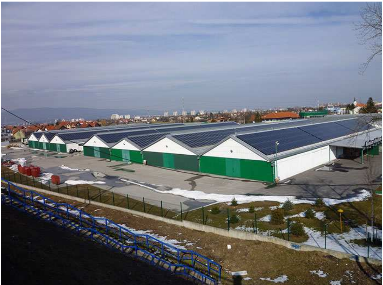
Slika 7.2.3 Solarna elektrana Petrokov; Izvor: www.geo-solar.hr
