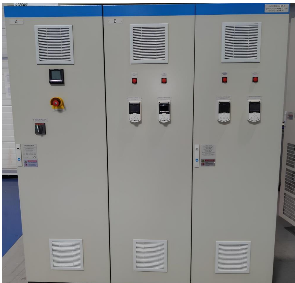
Slika 2. Ventilacija elektroormara.
