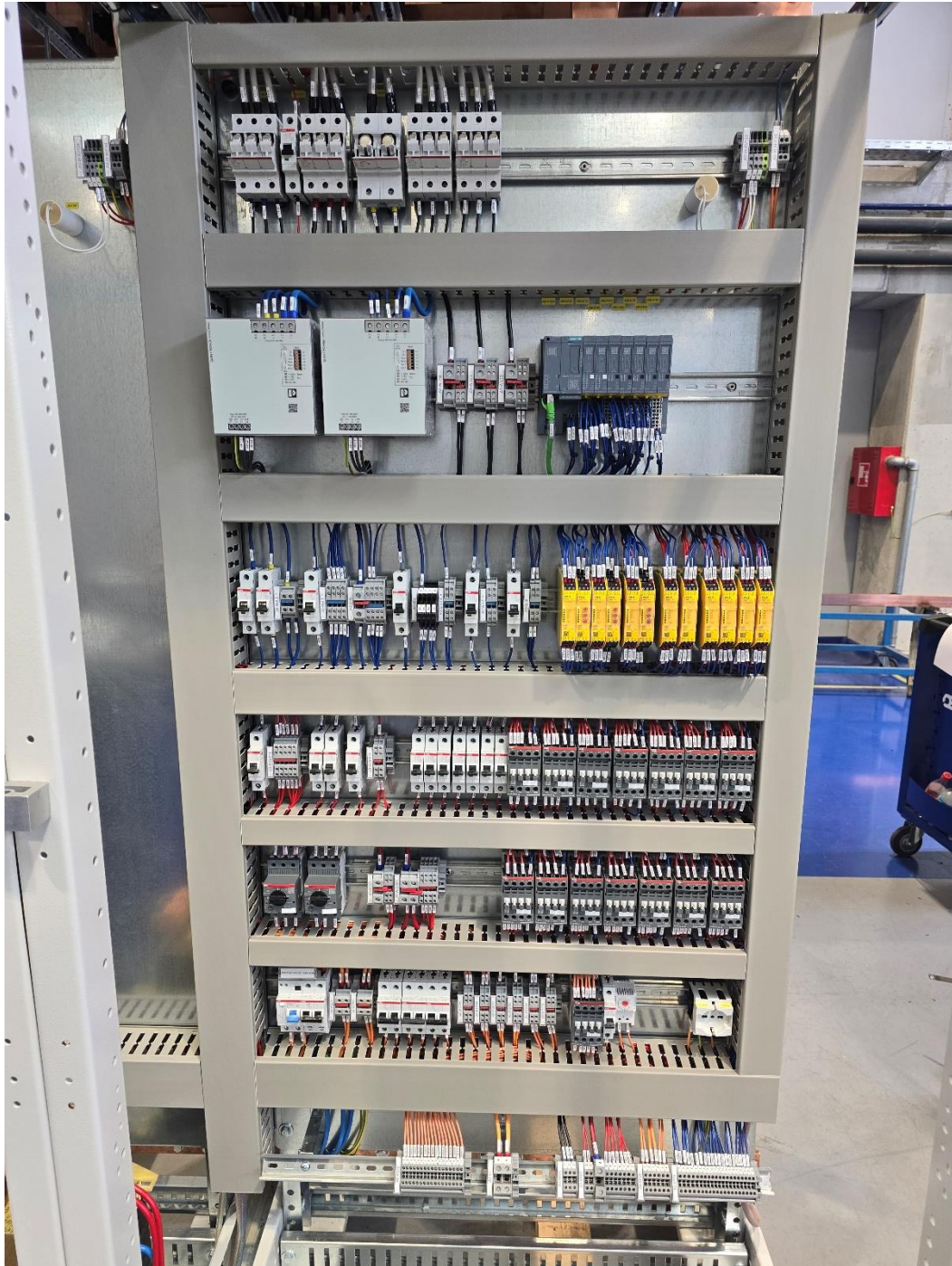
Slika 20. Dovršeno ožičenje temeljne ploče.
