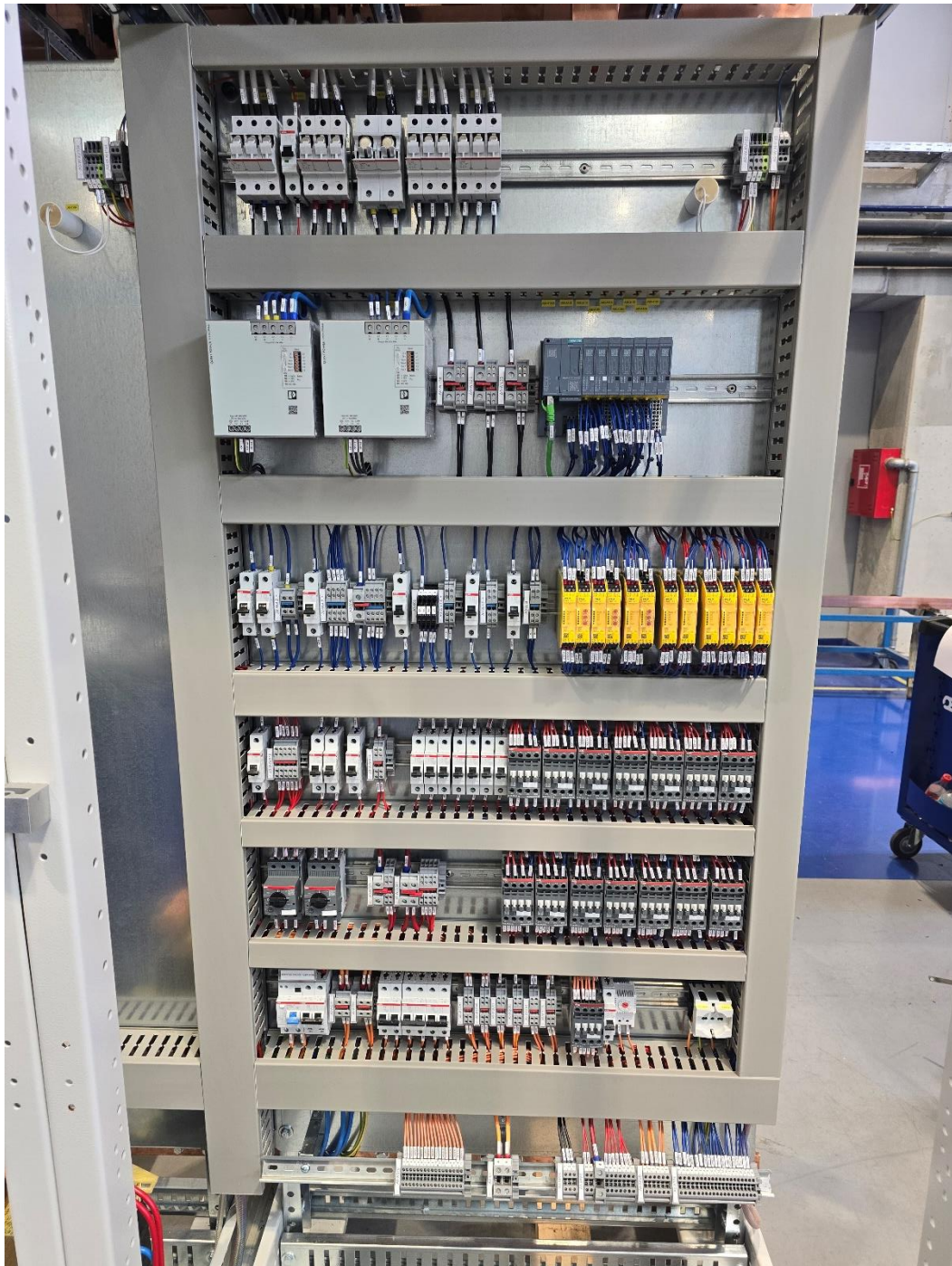
Slika 20. Dovršeno ožičenje temeljne ploče.
