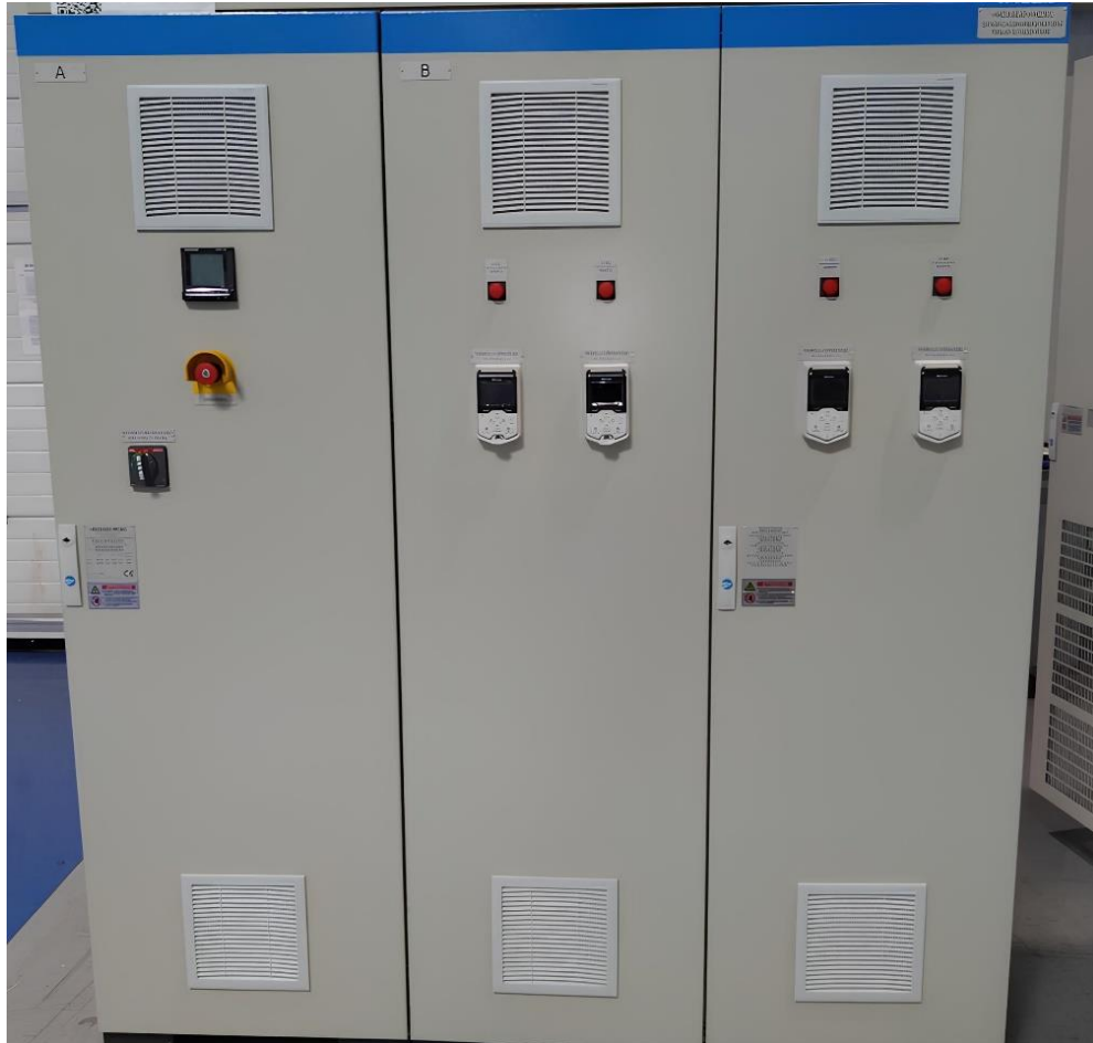
Slika 2. Ventilacija elektroormara.
