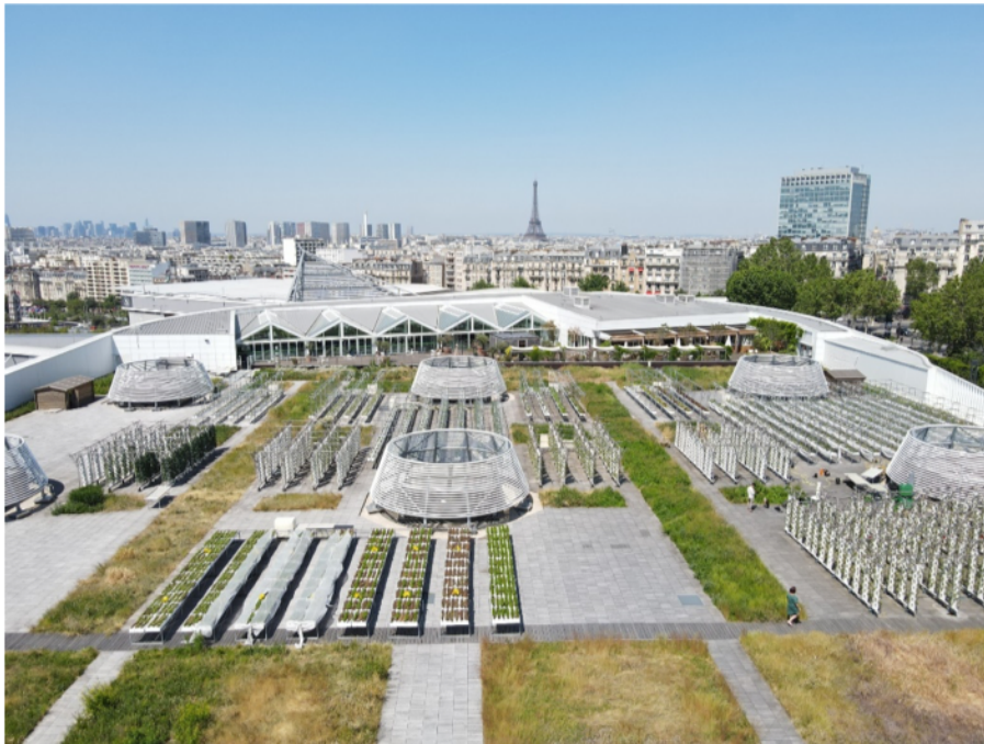
Slika 3. Prikaz jedne od tvornica biljaka u Parizu na vrhu zgrade
