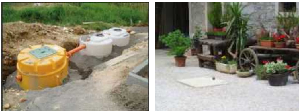
Slika 15. Prikaz zatrpavanja prečištača i spremnika te završni izgled
