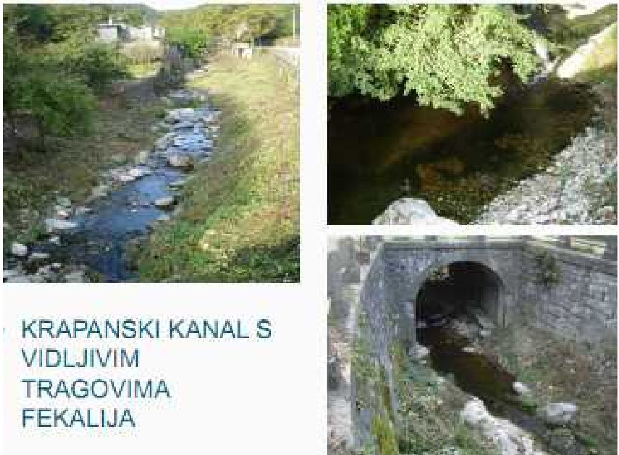
Slika 4. Prikaz postojećeg stanja Krapanskog kanala
