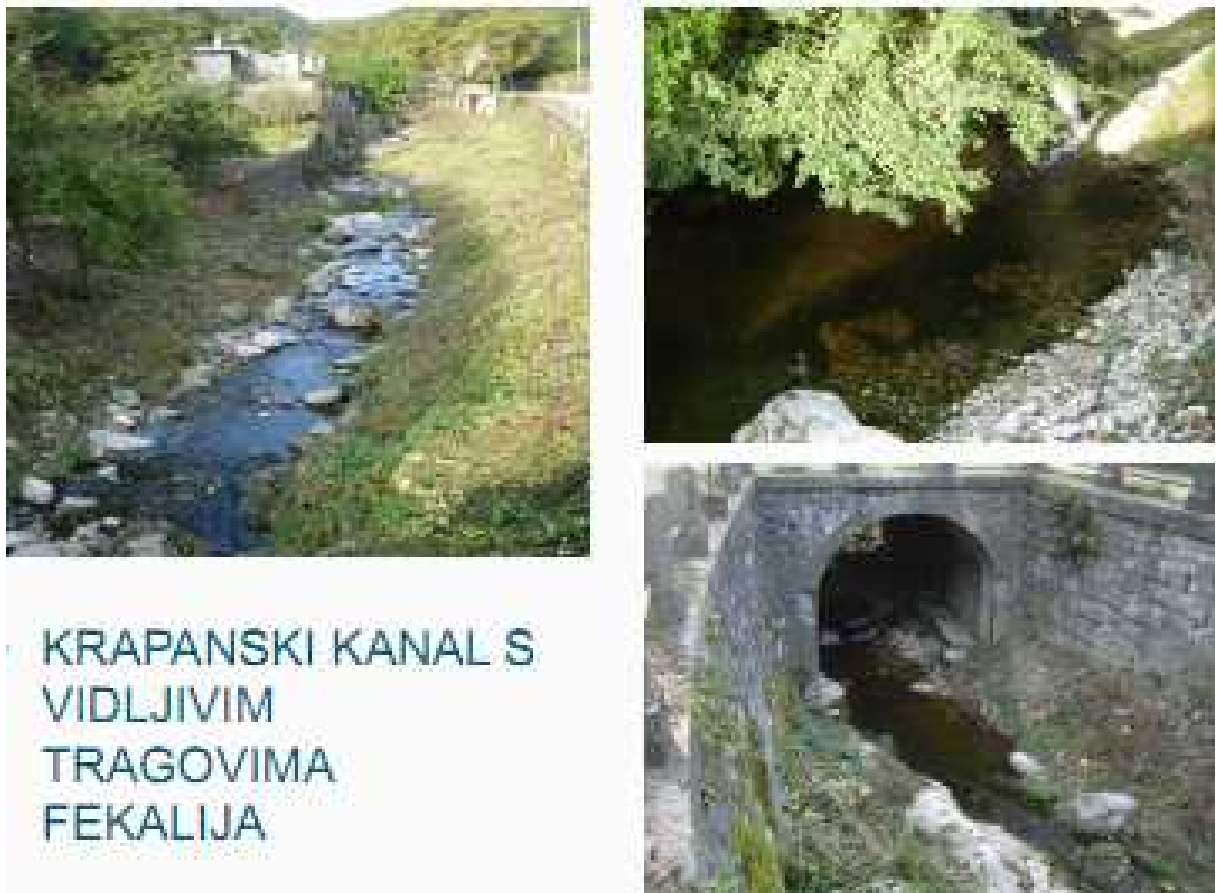
Slika 4. Prikaz postojećeg stanja Krapanskog kanala
