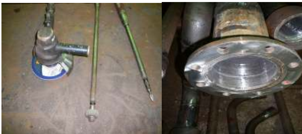
Slika 21. Alati za brušenje i cijevi nakon brušenja
