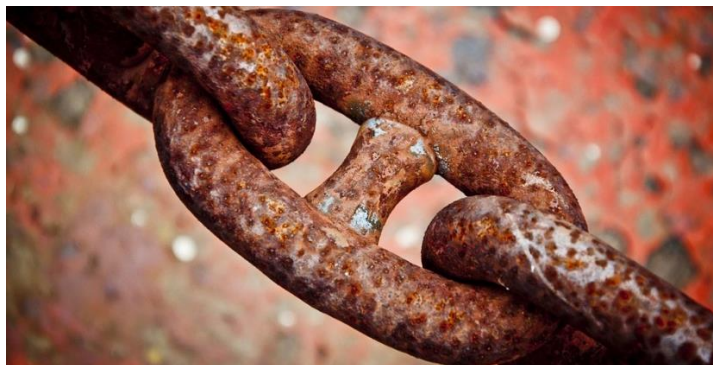
Slika 1. Primjer hrđanja željeza
