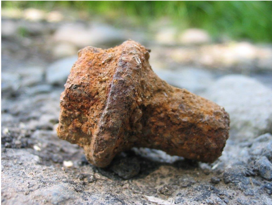
Slika 5. Primjer opće korozije vijka
