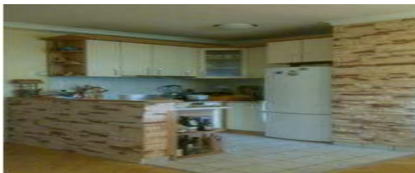
Slika 42. Zid obložen tučenim kamenom
