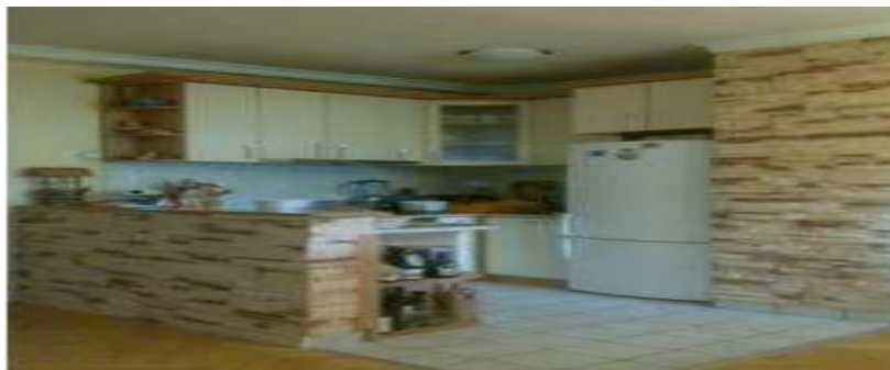
Slika 42. Zid obložen tučenim kamenom
