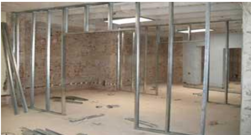
Slika 38. Konstrukcije pregradnih zidova za postavljanje knaufa
