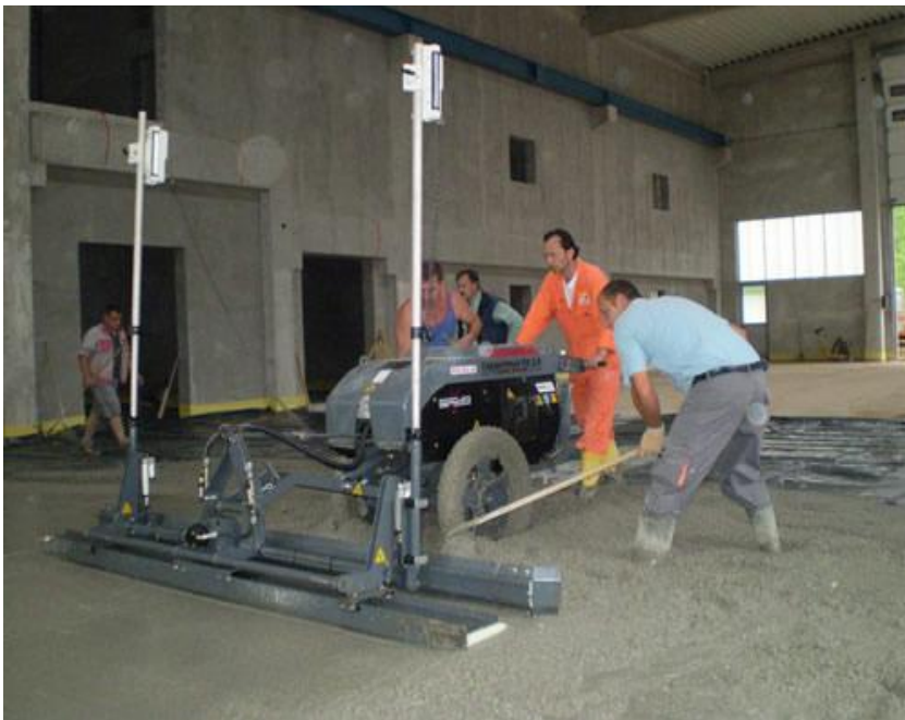
Slika 32. Poravnavanje laserskom vibro letvom
