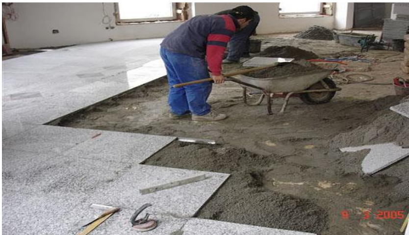
Slika 29. Postavljanje kamenih ploča na polusuho
