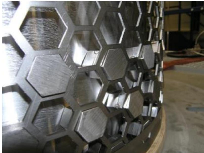
Slika 16. Postavljanje Hexadur pločica<sup>26</sup>
