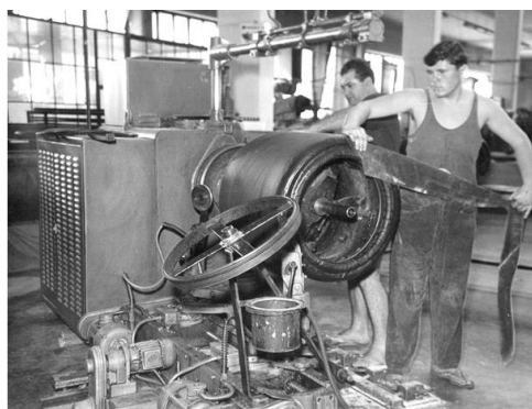
Slika 6 – Konfekcioniranje automobilskih guma u tvornici Borovo, 1960-tih
