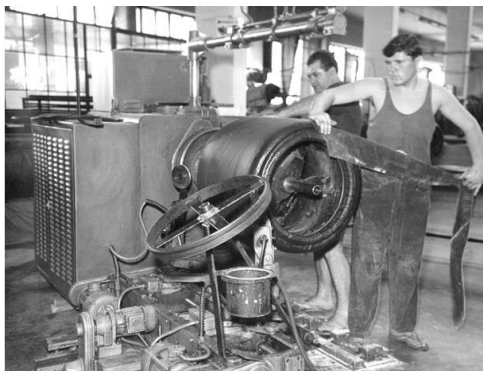
Slika 6 – Konfekcioniranje automobilskih guma u tvornici Borovo, 1960-tih
