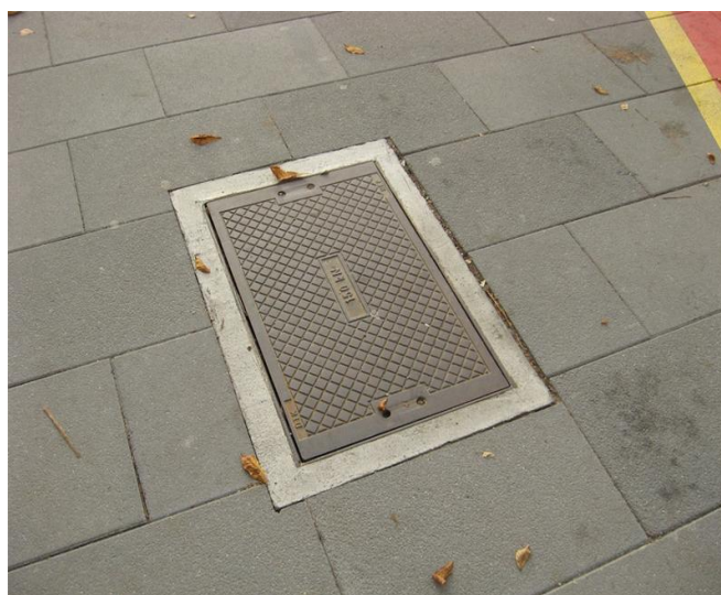
Slika 28: Montažni zdenac D1 (ŠxDxV 92x62x72 cm)
