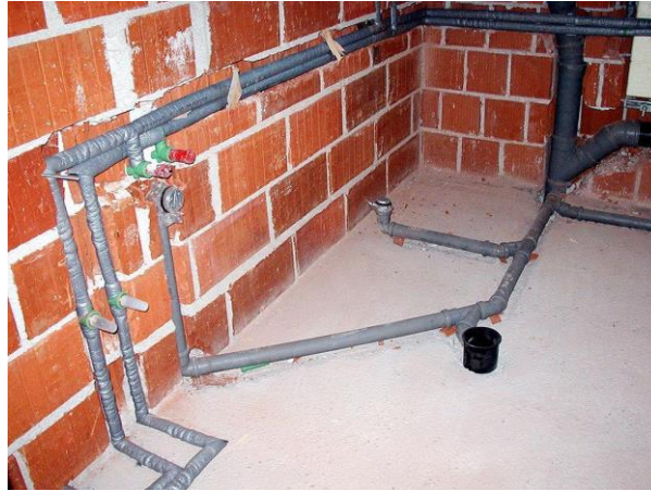
Slika 14 – Montaža vodovodne instalacije. Izvor 35
