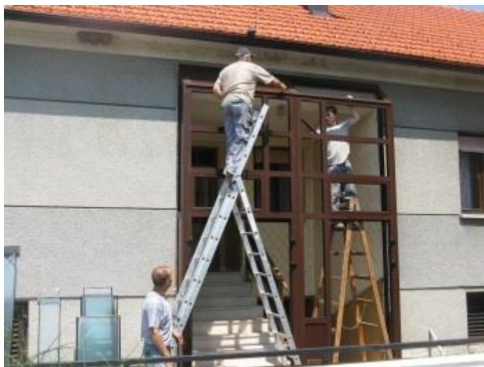
Slika 13 – Montaža stolarije. Izvor 34
