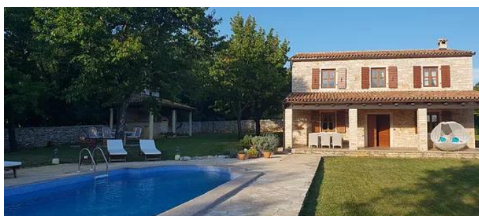
Slika 4 –Primjer rustikalne kuće za odmor. Izvor: 22
