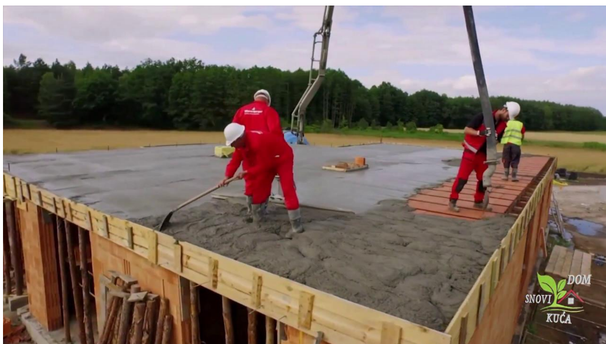
Slika 11 –Betoniranje deke. Izvor 32
