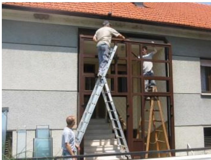
Slika 13 – Montaža stolarije. Izvor 34
