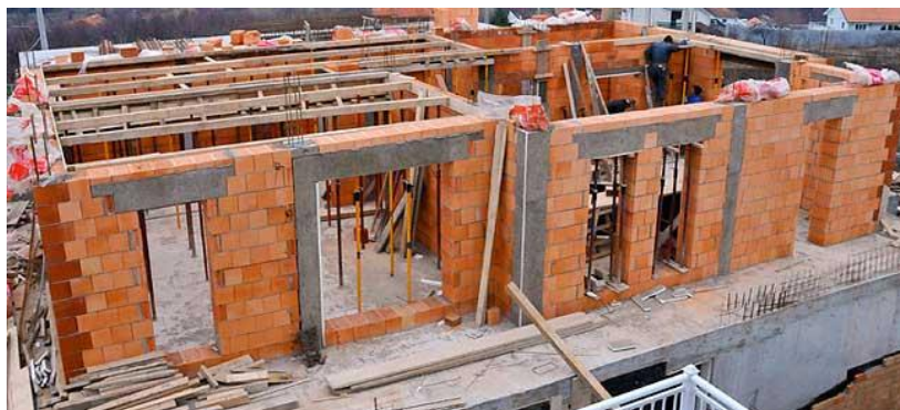
Slika 10 – Izgradnja prve etaže. Izvor 31
