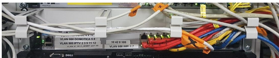
Slika 21: „Switch core u funkciji“
