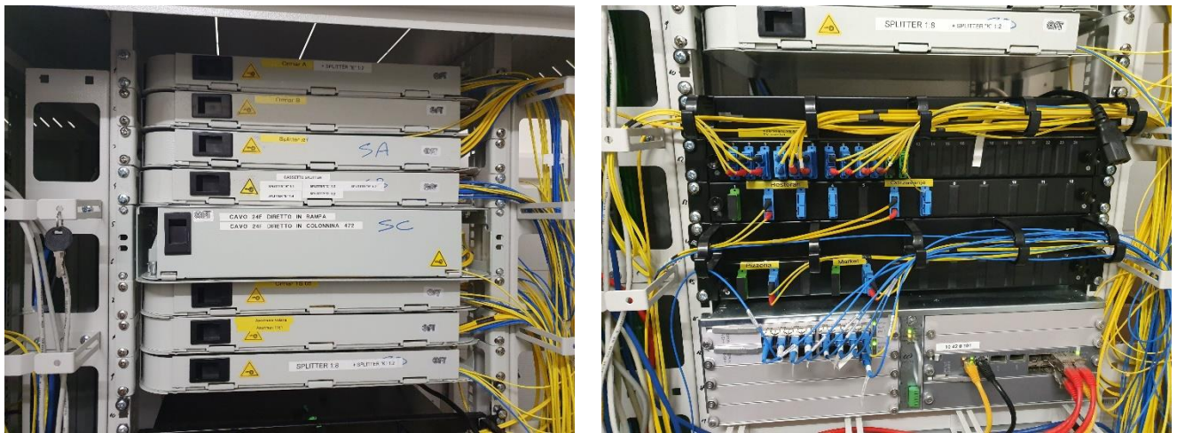
Slika 17: „Optička ladica s patch panelom“
