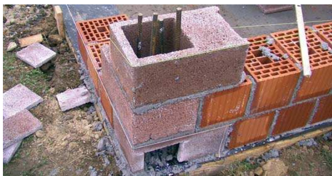
Slika 17. gradnja ciglom, izvor www.wienerberger.hr
