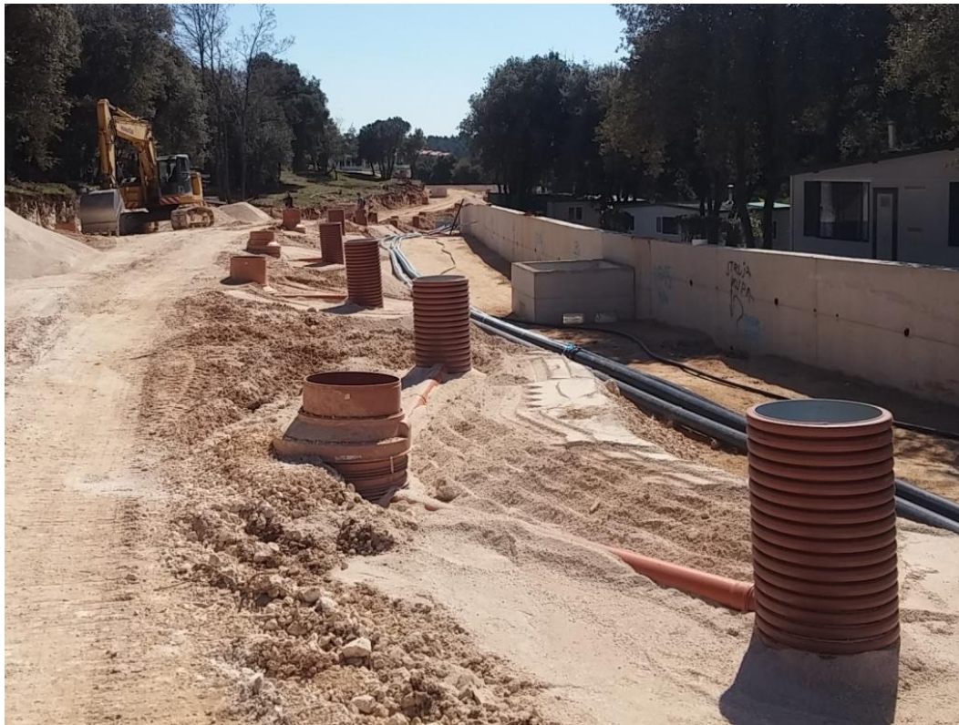
Slika 17: ugradnja cijevi (izvor: autor)
