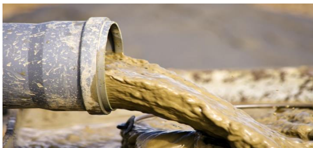
Slika 33: ispuštanje otpadnih voda (izvor: https://www.pipelife.hr/hr/ )
