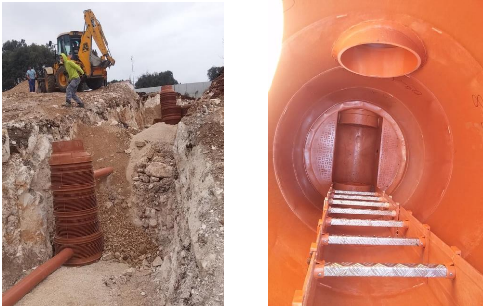
Slika 18: kaskadno savladavanje kosina (izvor: autor)
