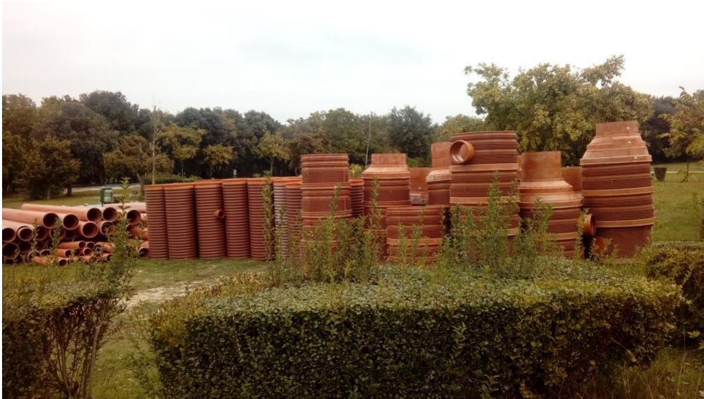
Slika 13: plato za uskladištenje cijevi i okana (izvor: autor)
