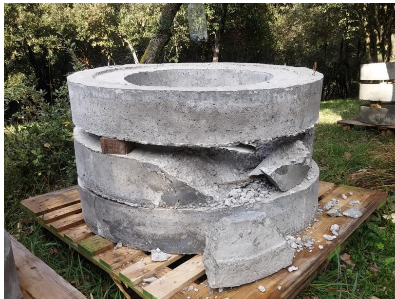
Slika: 21. Betonski rasteretni prstenovi (Izvor: autor)
