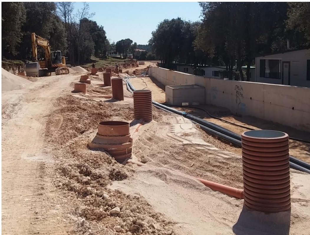
Slika 17: ugradnja cijevi (izvor: autor)
