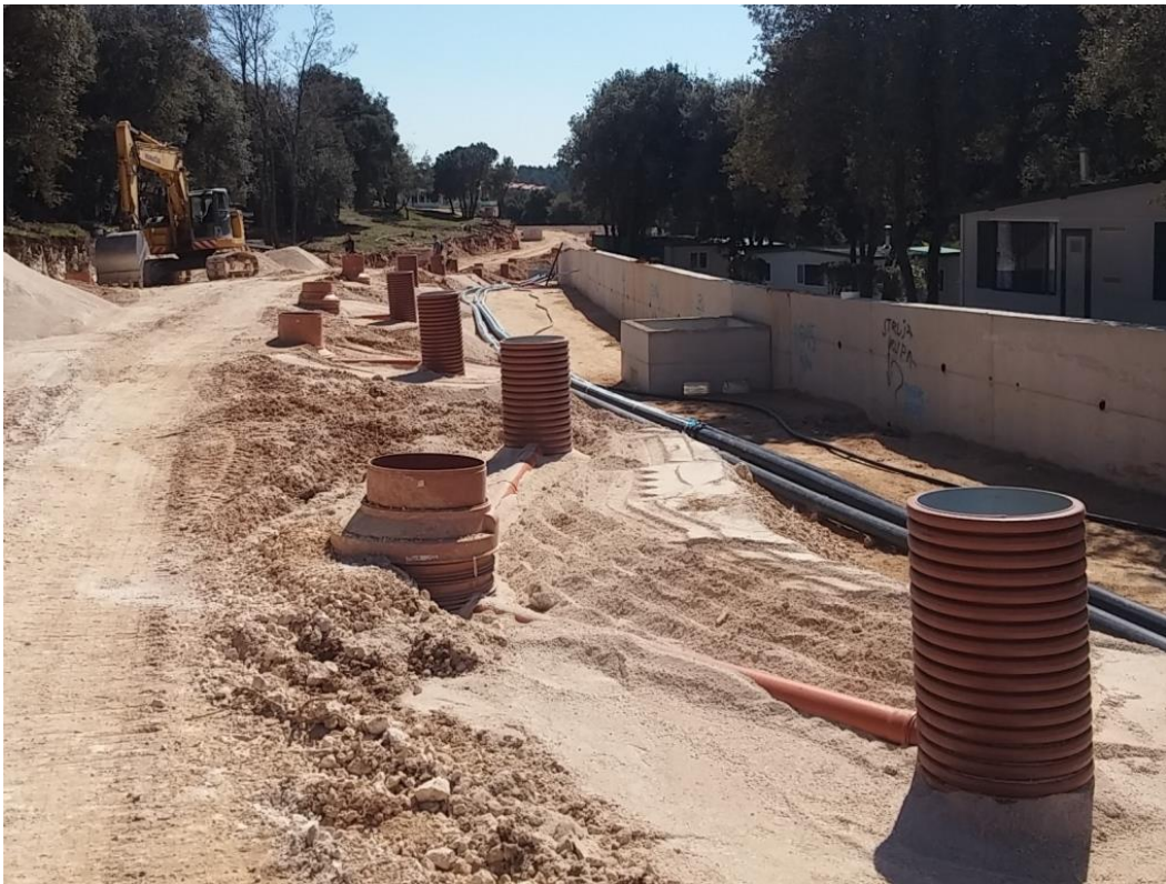
Slika 17: ugradnja cijevi (izvor: autor)
