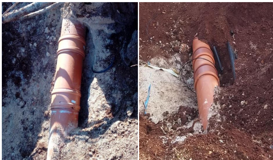
Slika 28: sanacija oštećenih cijevi (izvor: autor)
