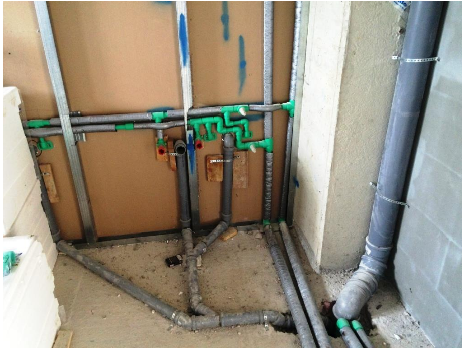
Slika 26: ugradnja odvoda (Izvor: autor)
