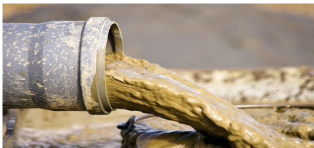
Slika 33: ispuštanje otpadnih voda (izvor: https://www.pipelife.hr/hr/ )
