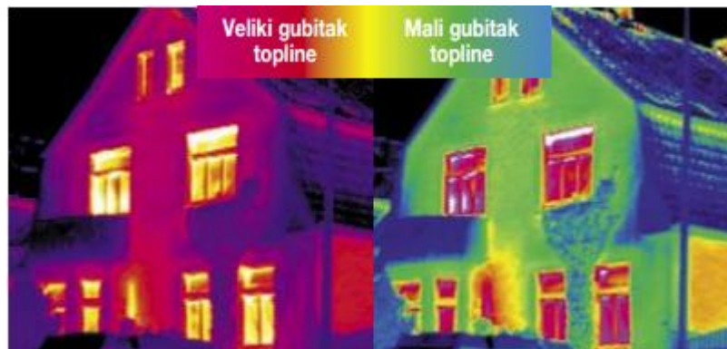
Slika 1. Razlika u gubicima topline izolirane i neizolirane kuće
