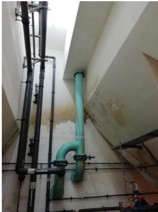
Slika 22: Cijevi za odvod izbistrene vode s mogućnošću odabira za povratak u proces kondicioniranja ili slanja u recipijent [Autor]
