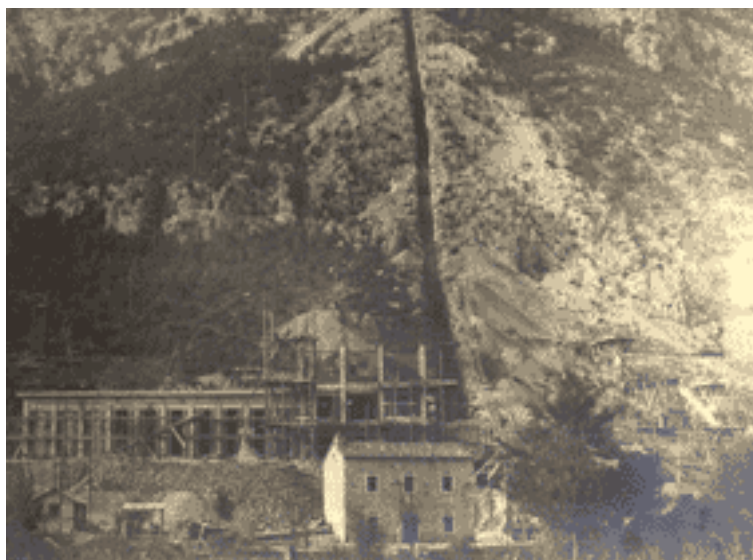
Slika 2: Izgradnja crpne stanice Sv. Stjepan [15]
