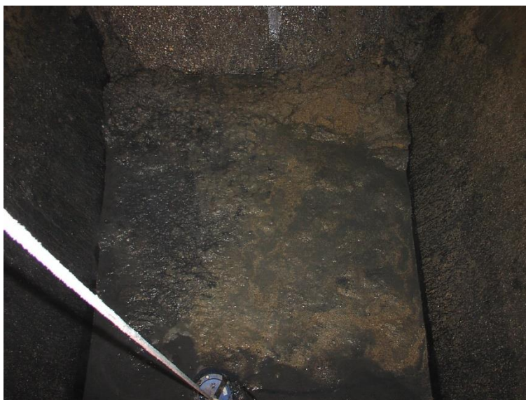
Slika 25: Ispumpavanje zaostalog staloženog mulja potopnom pumpom [15]
