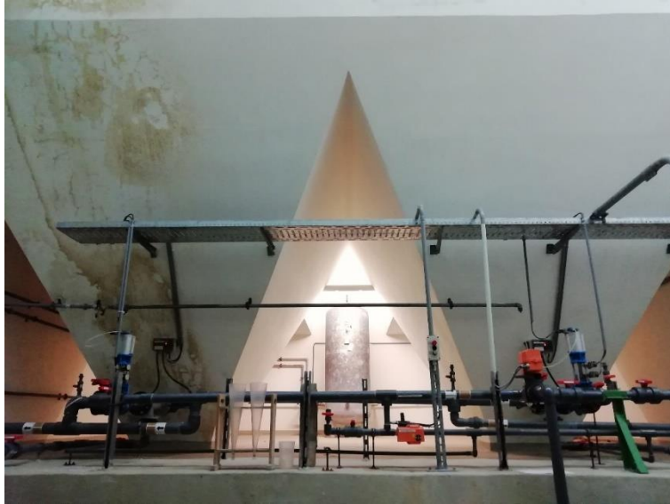
Slika 14: Konusni dio pločastih taložnica gdje se taloži talog suspendiranih tvari [Autor]
