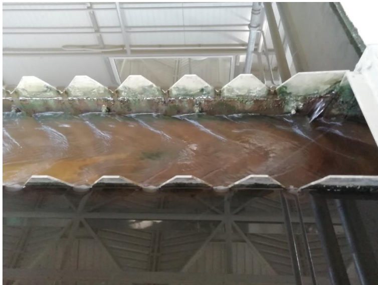
Slika 15: Detalj pločastog taložnika u radu [Autor]
