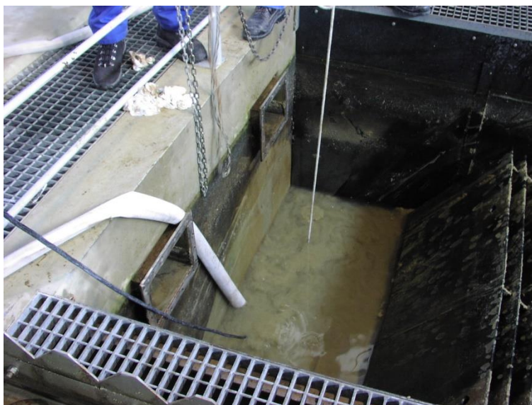
Slika 24: Ispumpavanje mulja potopnom pumpom [15]
