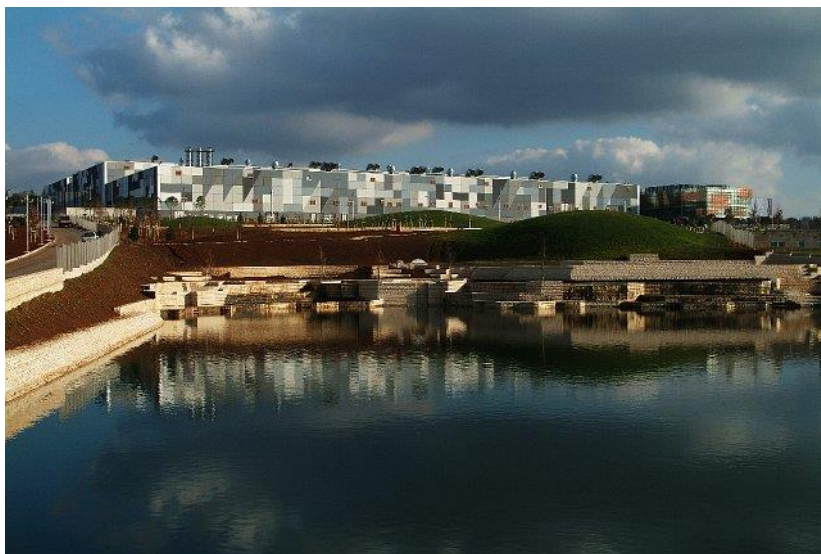
Slika 1. Tvornica duhana Rovinj smještena u Kanfanaru
