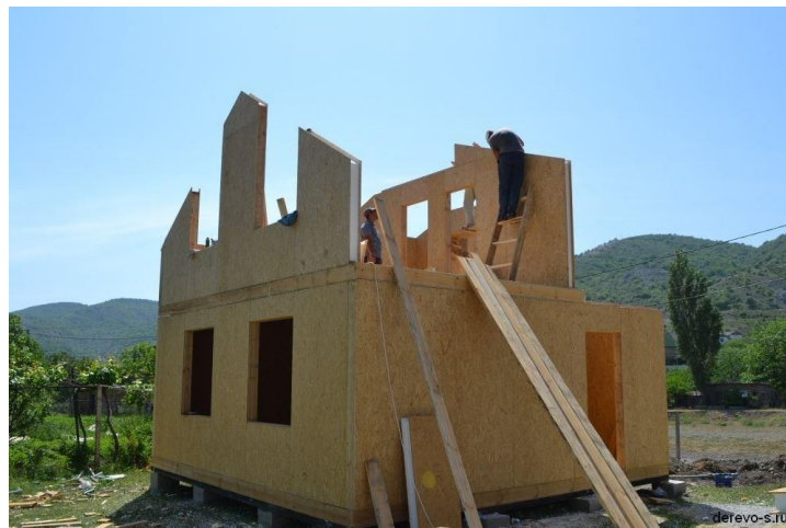
Slika 8. Postavljanje gotovih elemenata na gradilištu
