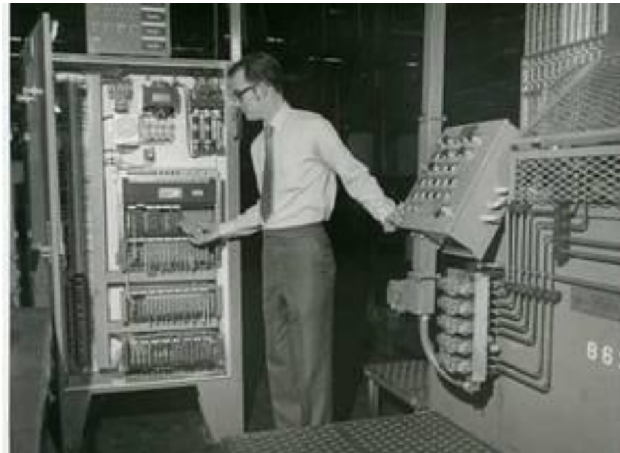
Slika 3 - Programabilni logički kontroler
