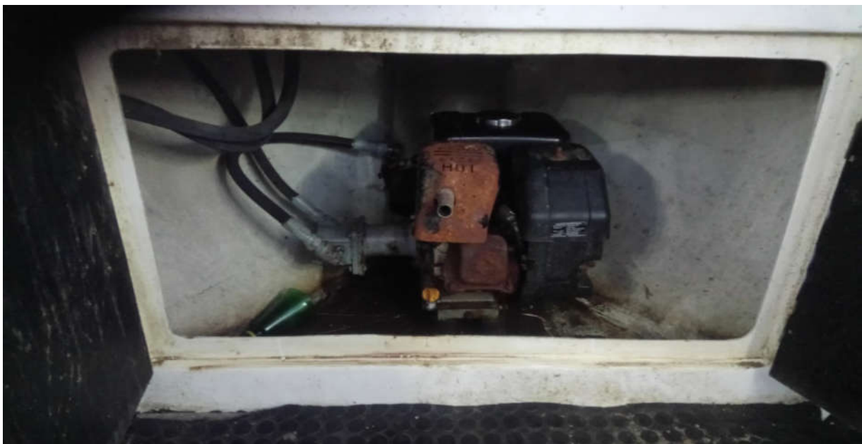
Slika 22. Prikaz ugradnje motora Kohler ispod pramca brodice.
