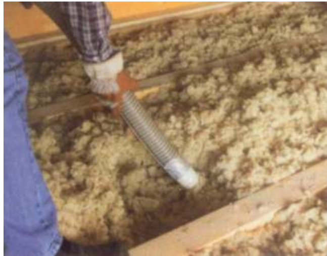
Slika 10. Upuhivanje toplinske izolacije od ovčje vune
