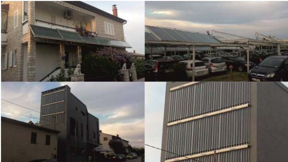
Slika 31. Razni primjeri montaže solarnih panela
