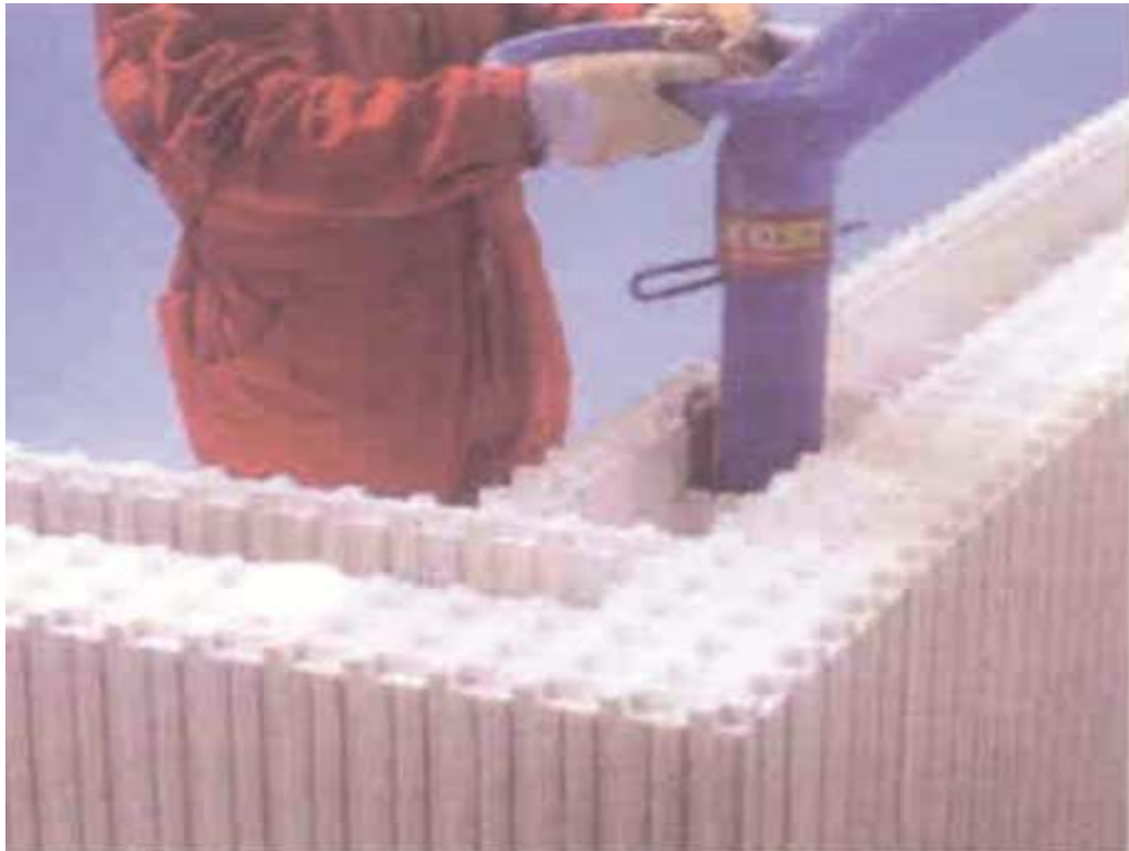
Slika 5. Gradnja s oplatnim elementima od polistirena
