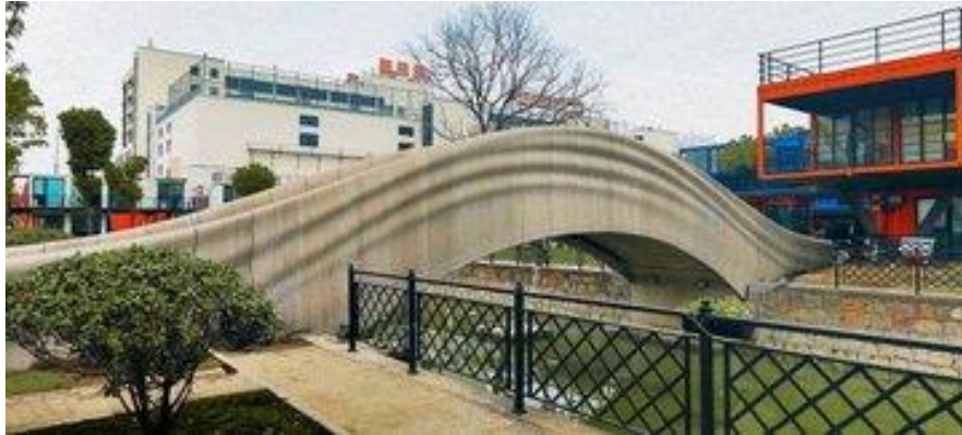
Slika 20. Primjena aditivne tehnologije u graditeljstvu
