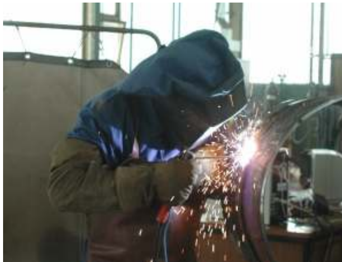
Slika 2.1.3.: Zavarivanje cijevi REL postupkom [12]
