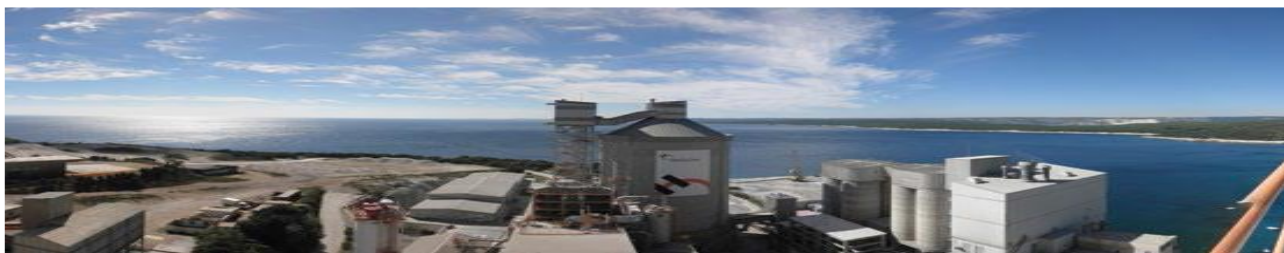
Slika 4: Holcim Hrvatska: sjedište tvrtke u Koromačnu
