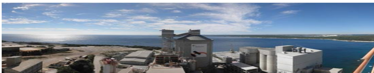
Slika 4: Holcim Hrvatska: sjedište tvrtke u Koromačnu
