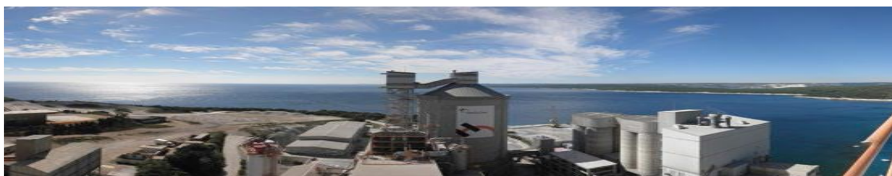
Slika 4: Holcim Hrvatska: sjedište tvrtke u Koromačnu
