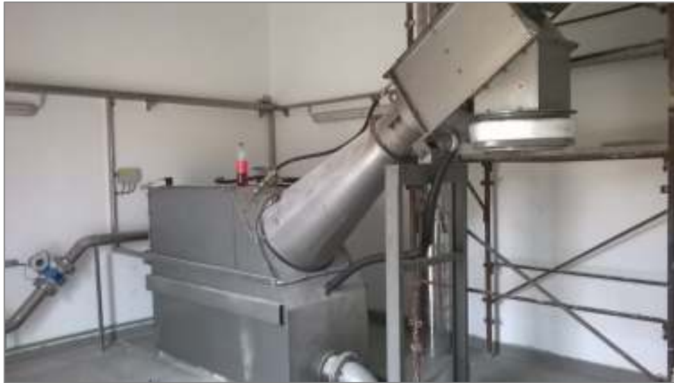
Slika 10: stanice za prihvat i preradu otpadnih voda iz septičkih jama Izvor: Autor
