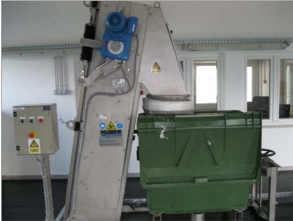
Slika 11: Automatska rešetka
