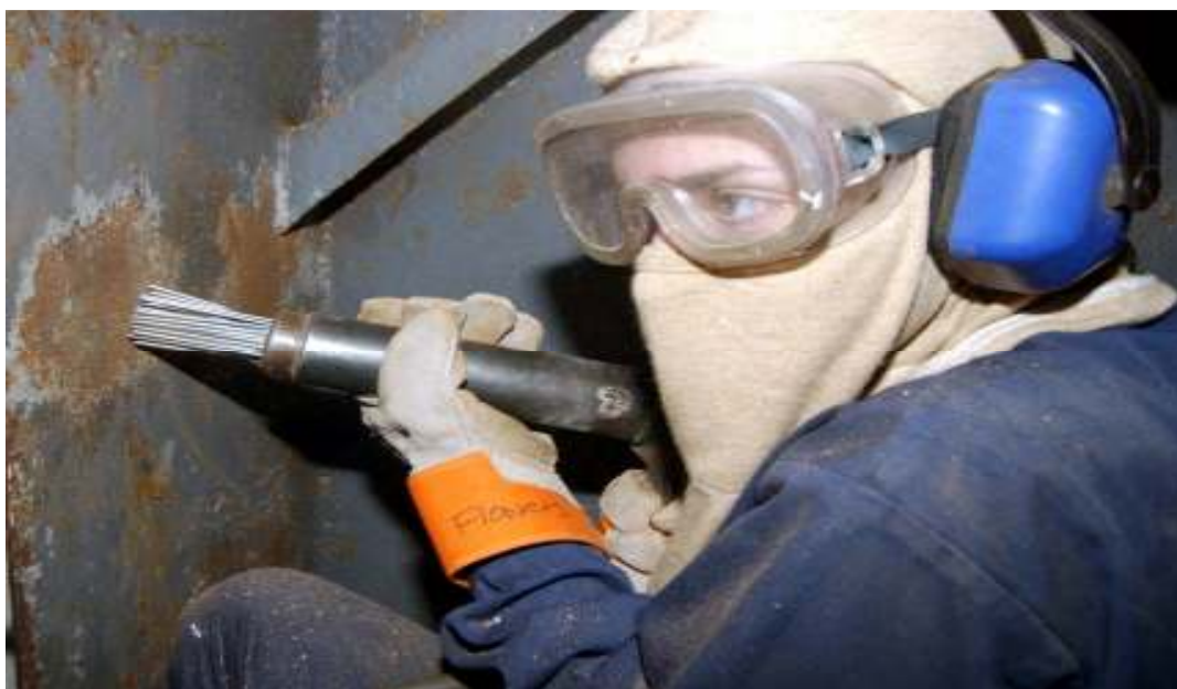
Slika 15: Uklanjanje korozivnih produkata na brodu
