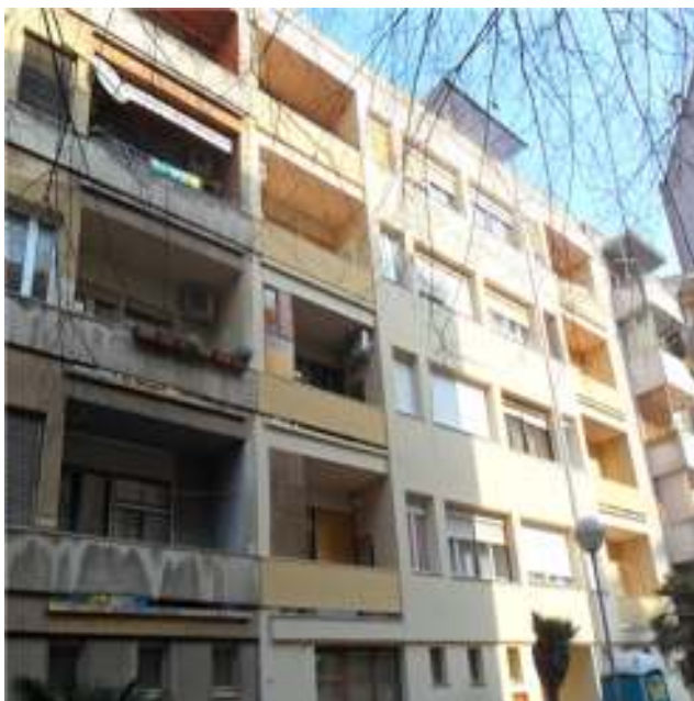
Slika 9.: Pročelja nakon obnove
