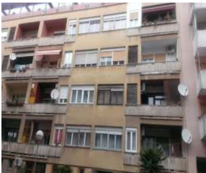
Slika 8.: Pročelja prije obnove
