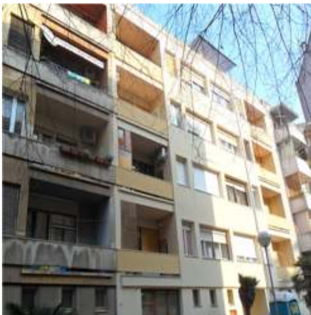
Slika 9.: Pročelja nakon obnove
