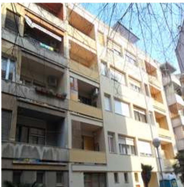
Slika 9.: Pročelja nakon obnove
