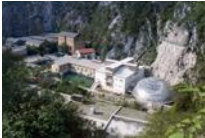
Slika 18: Komunalno društvo Vodovod i kanalizacija d.o.o. Rijeka
